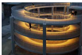
Bild Titelseite: Fussgänger-Passerelle, Attisholz-Areal, Riedholz bei Solothurn; Bauherr: Halter AG, Entwicklung, Hardturmstrasse 134, 8005 Zürich; MÜLLER-STEINAG ELEMENT AG
