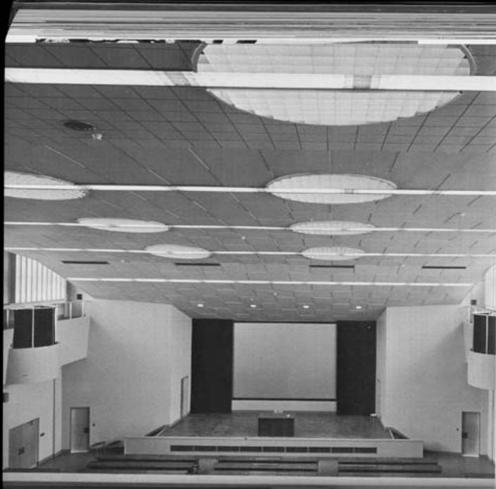
249. 明治大学和泉第二校舎大教室 九百人教室教壇側を見る。床はプラスチック、灰色。壁は有孔ベニアメント張り、下に岩綿入れ、両側壁斜にする。窓はアルミサッシ引違いが二重、内に木造ベニアの回転格子つき、銀色ベント張り、天井は有孔吸音チップス張り、丸型天窓鉄筋カーブつき。教壇には中央壁に映写幕つき、教室中にマイクスクープ特殊打鍵と拡声器を備える。映画はさき後方に機械室を設けて写せるように企てた。この教室は中三階と三階、四階を占めている。
