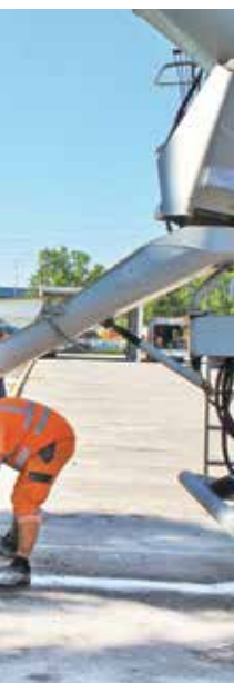
Abbildung 5: Herstellung der Betonoberfläche für den Versuchstunnel
