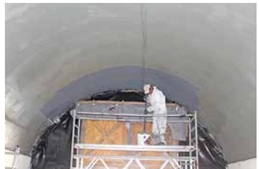
Abbildung 7: Herstellen der Beurteilungszustände im adaptierten Versuchstunnel a: Verlegen der Betonfahrbahn b: Verlegung von Randplatten c: Installation der Lampen d: Streichen der Tunnelinnenschale mit Deckenanstrich (Quelle: SMG)
