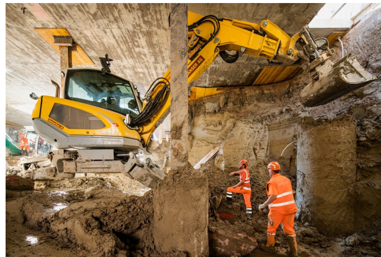
6 Aushub - Deckelbauweise
