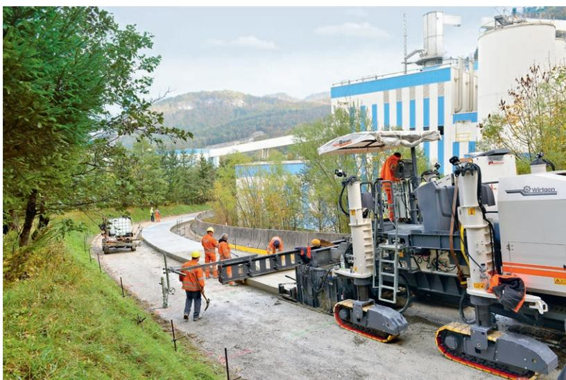
Abbildung 17: Einbau in steilem Gelände
