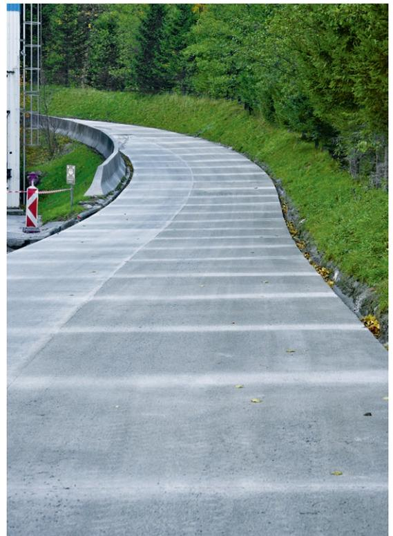
Abbildung 19: Manueller Betoneinbau im Bereich der Kurvenverbreiterung
