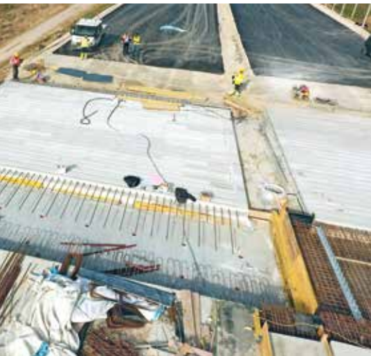
Technische Details Fahrbahnübergang: Fertigteil-Elemente auf der Gleitplatte nehmen die Bewegung auf. Rechts oben: Gesamtansicht der Satzengrabenbrücke während der Bauzeit.
