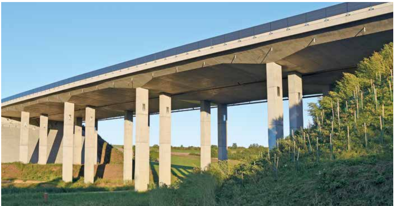
Satzengrabenbrücke nach Erstellung.
