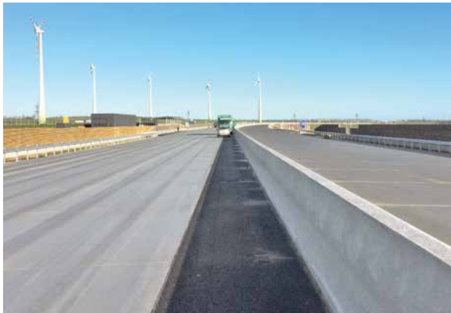
Ausführung der Grindingstruktur auf der A5. Oben links: Trägerwelle mit Diamantscheiben.
