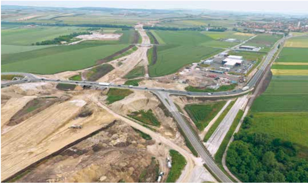
Vorher/nachher: Die Brücke Ü17 im Baulos 1 während der Bauzeiten und nach Fertigstellung. Beide Kreisverkehre wurden in Beton ausgeführt (großes Bild rechts).
