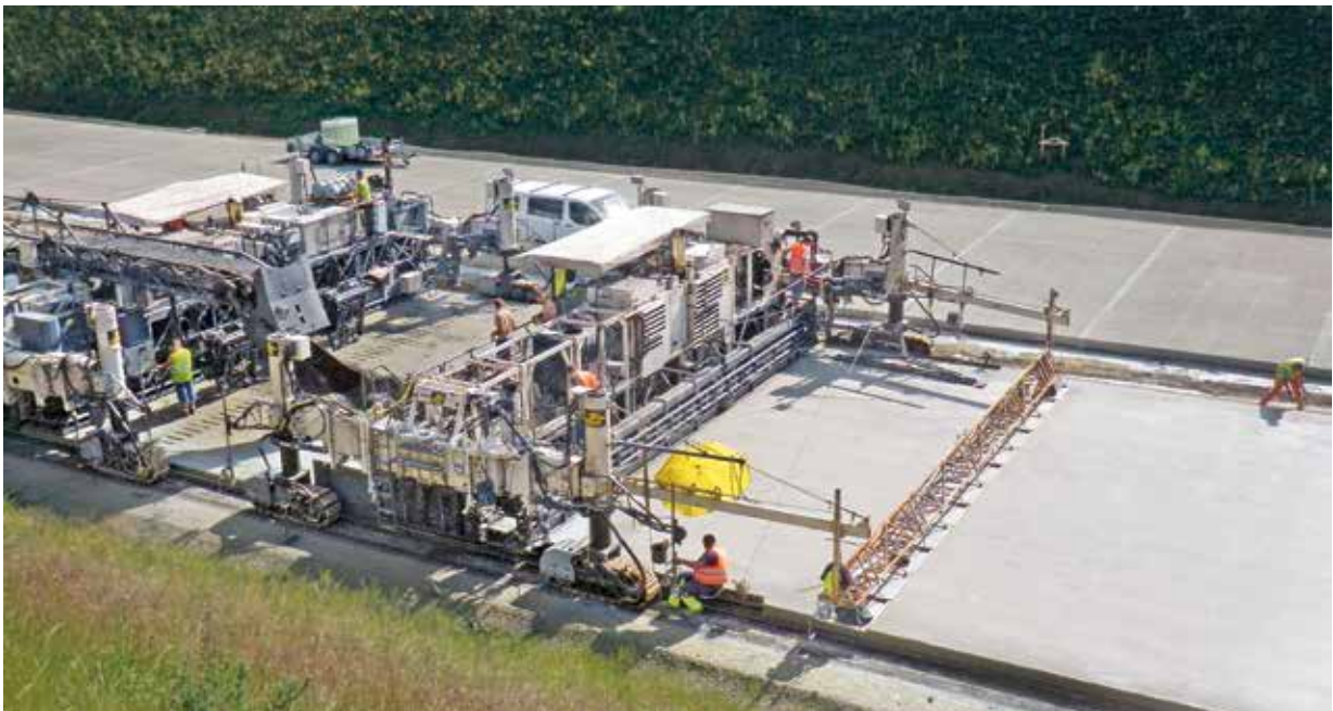
Einbau der Betondecke.
