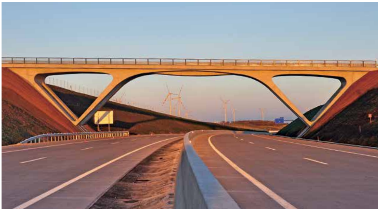
Mit der Satzengrabenbrücke und der A5.Ü20 wurden zwei Bauwerke innovativer Ingenieurbaukunst im Dezember 2017 dem Verkehr übergeben.
