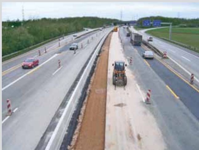
Bild 7: Bau einer frei aufgestellten Betonschutzwand
