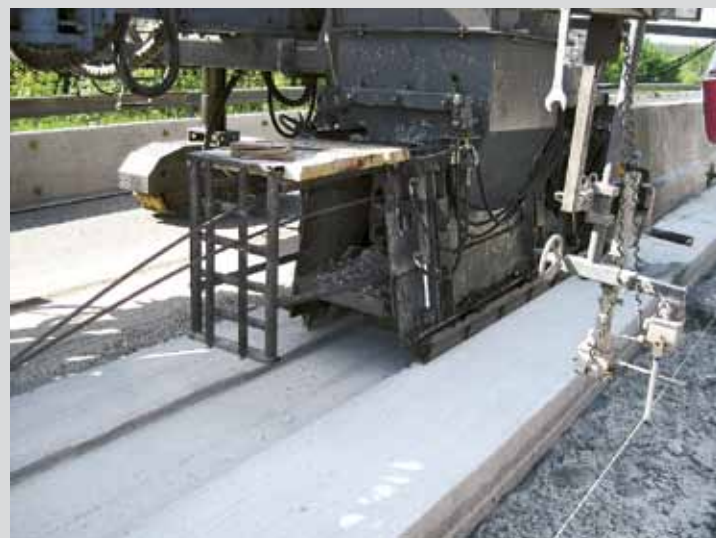
Bild 8: Bau einer eingespannten Betonschutzwand
