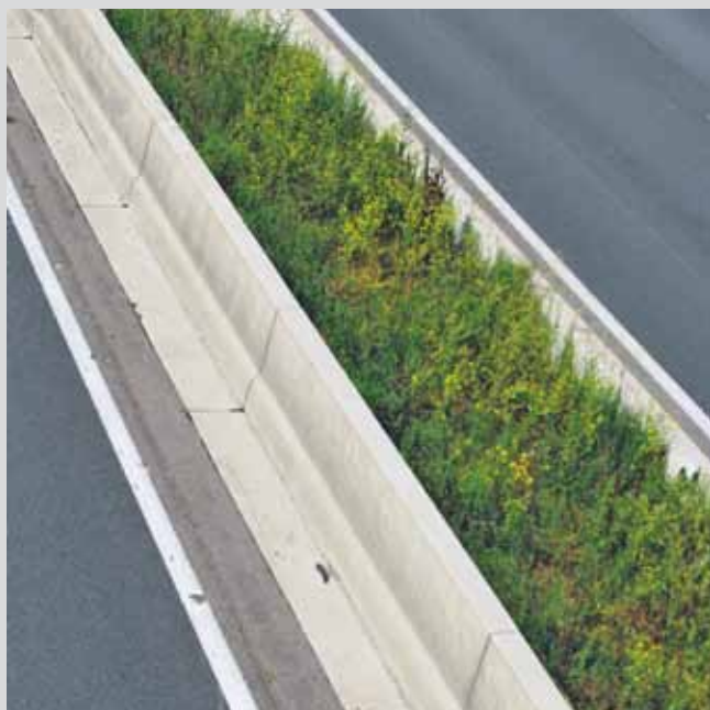
Bild 5: Betonschutzwand mit Step-Profil
