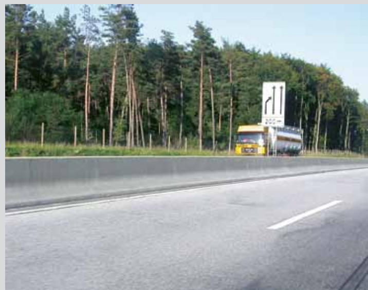
Bild 6: Betonschutzwand mit New-Jersey-Profil
