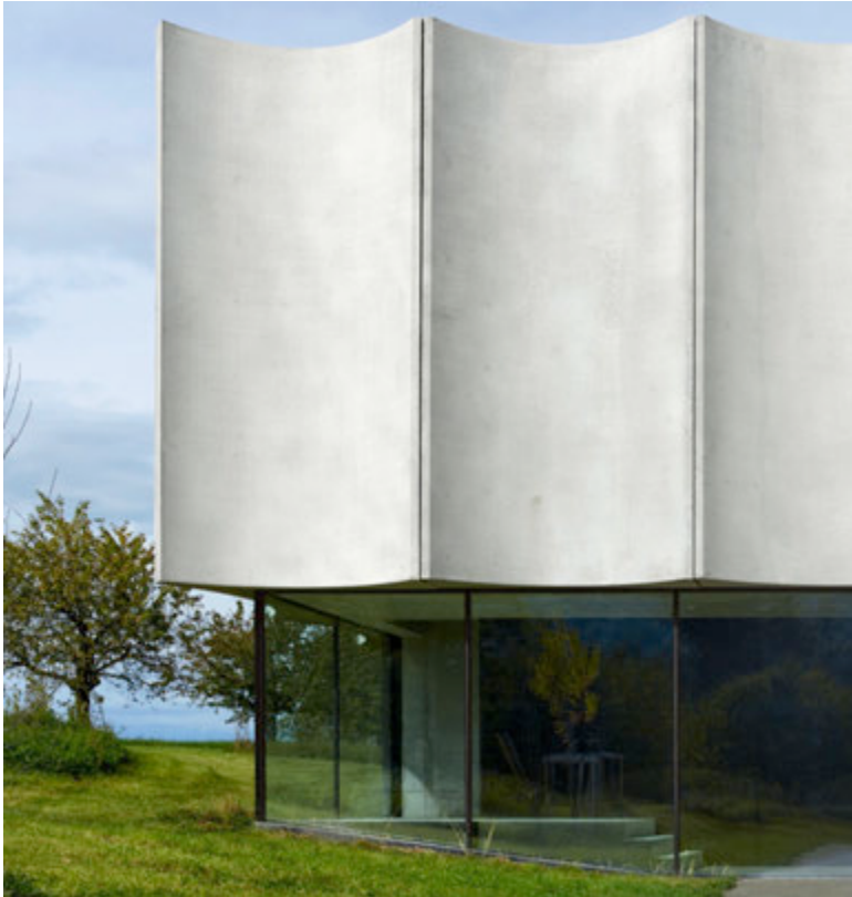
Ersatzneubau Halle Grossbühl Rodgersdorf SO 2005 - 2014
