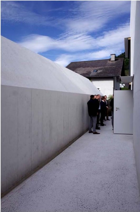
Vertikal- und schräg geschalter Ort beton
