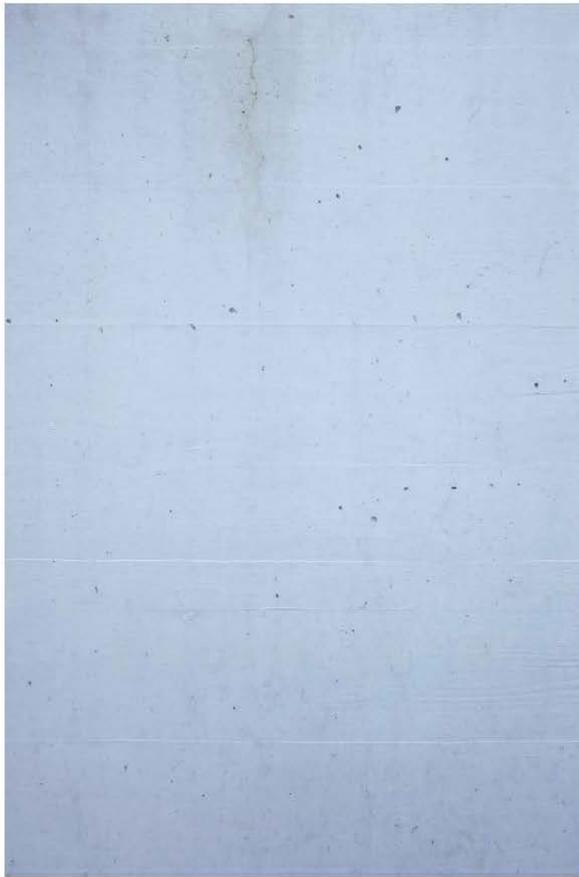
Struktur der Brettschalung
