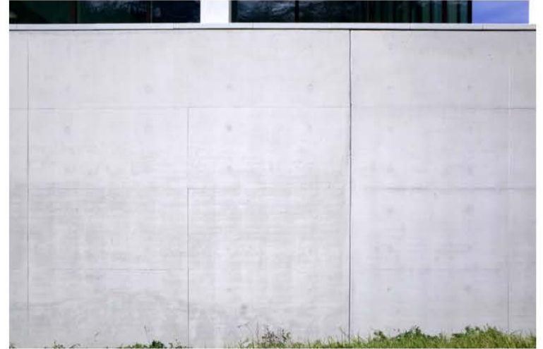
Ortbetonfassade aus der Nähe, sichtbar hier die Betonieretappen im „Streiflicht“
