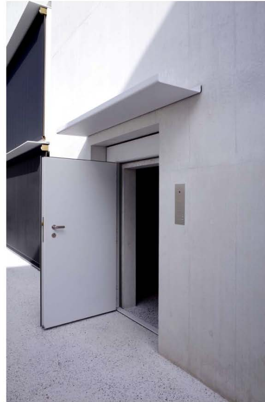
Unterschiedliche Oberflächenbehandlung der gleichen Betonmischung für Boden und Wand. Eingang „Stadthaus“
