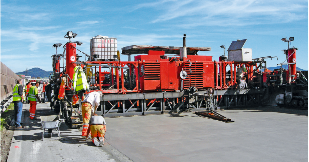
Fig. 7 Mise en place de la nouvelle couche de béton supérieur
