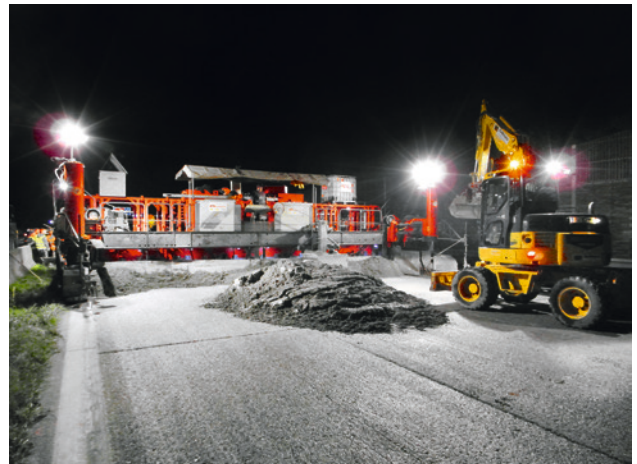
Fig. 8 Mise en place de nuit du revêtement en béton
