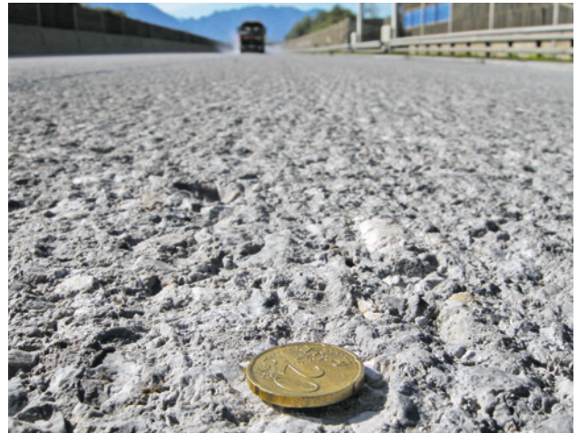
Fig. 5 Surface après nettoyage au HDW
