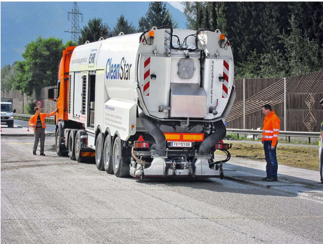
Fig. 6 Nettoyage par jet d'eau à haute pression (HDW)
