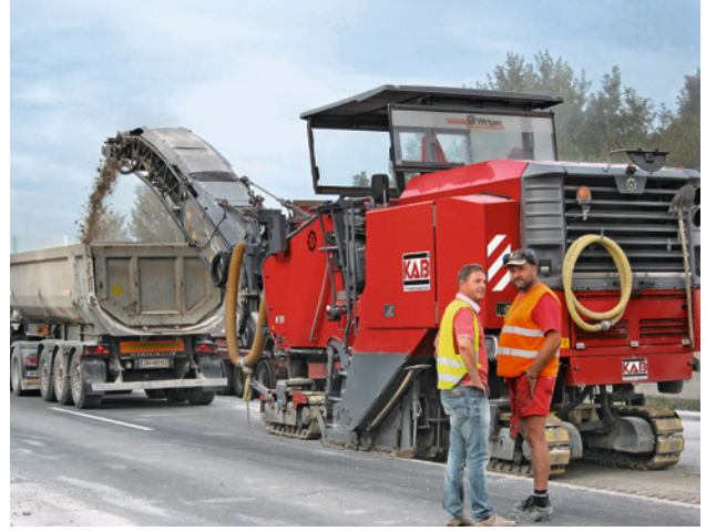
Fig. 3 Enlèvement à la fraiseuse d'une couche de 8 cm
