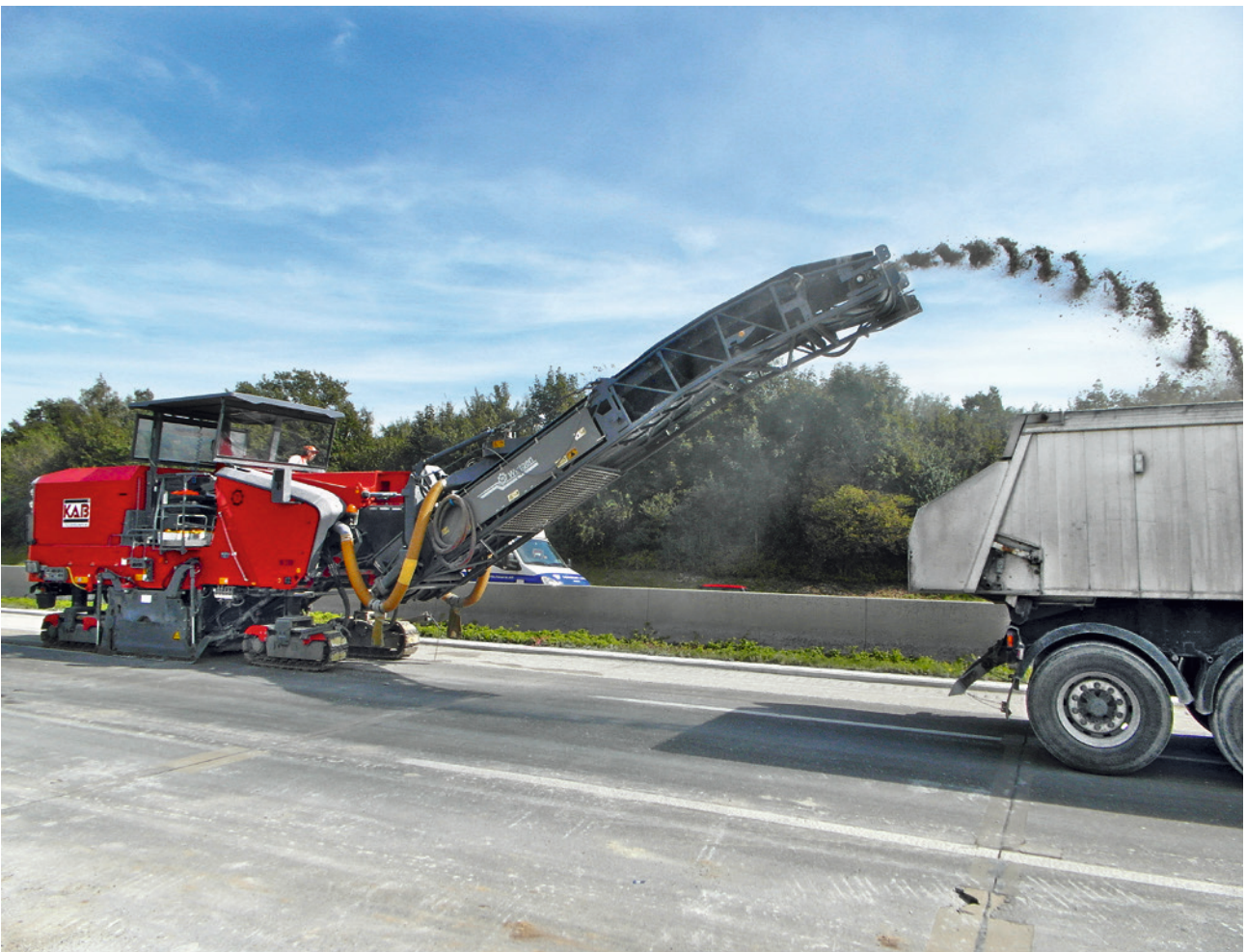
Fig. 4 Enlèvement à la fraiseuse d'une couche de 8 cm
