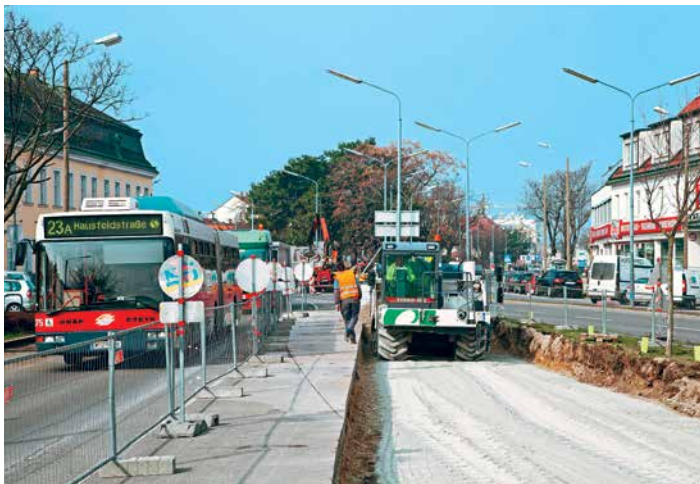
Fig. 9 Tronçon 1 : Stabilisation au ciment dans le secteur du Kagraner Platz
