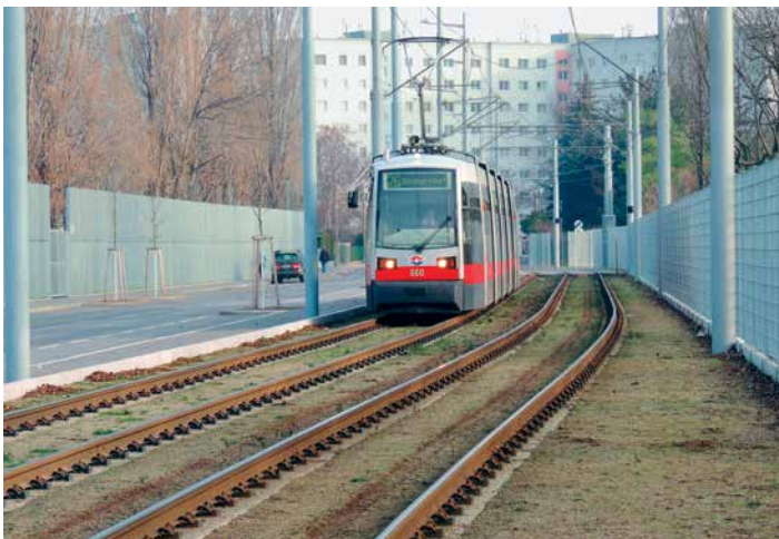
Fig. 5 Tronçon 3 : Voies végétalisées longeant la Oberfeldgasse
