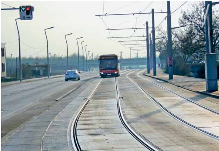
Fig. 7 Tronçon 3 : Voies sur site propre longeant la Hausfeldstrasse
