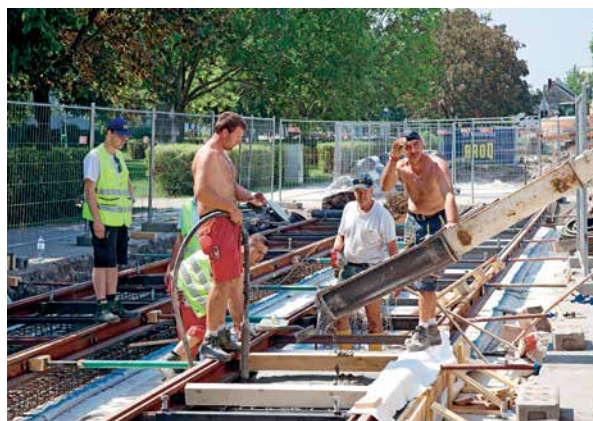
Fig. 10 Pervibrage du béton coulé sur place
