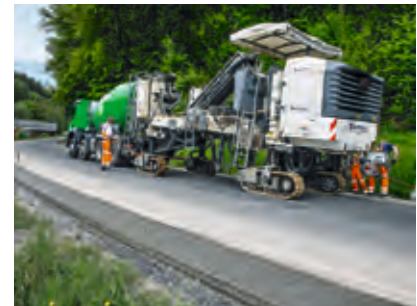
B460 Hüttenthal-Marbach (HE) Mise en œuvre de la deuxième bande dérasée au moyen d'un finisseur à coffrage glissant offset
