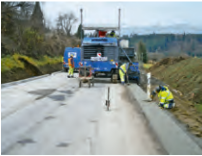
K1021 Merklingen (Weil der Stadt, BW) Bande dérasée en béton achevée, pose des délinéateurs
