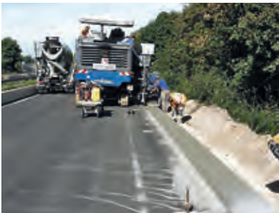
B45 Dreieck Dieburg-Rödermark / Ober-Roden (HE) Mise en œuvre du béton d'accotement, cure
