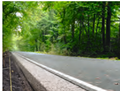
L208 Aumühle-Kuddewörde (SH) Bande dérasée réalisée au fi de guidage
