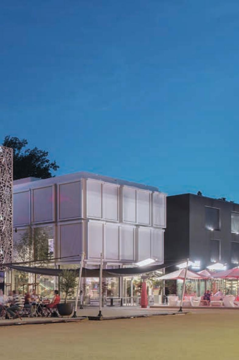
Die Obergeschosse sind in ein filigranes Netz aus Verästelungen gekleidet, die aus Ultra-Hochleistungsbeton gefertigt wurden. Dieses dient den Nutzenden als Sicht- und Sonnenschutz. (Thomas Jantscher)
