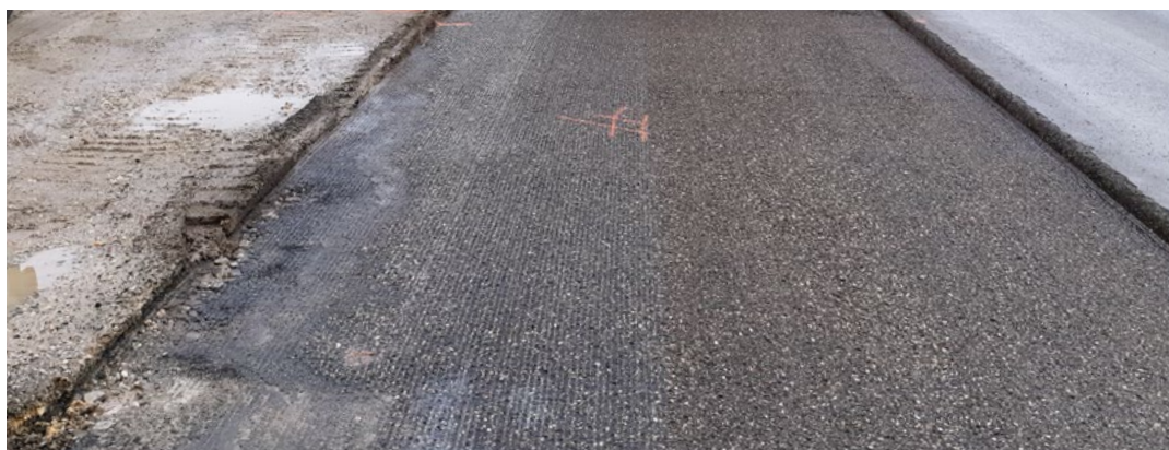
Surface d'asphalte fraisée et nettoyée
