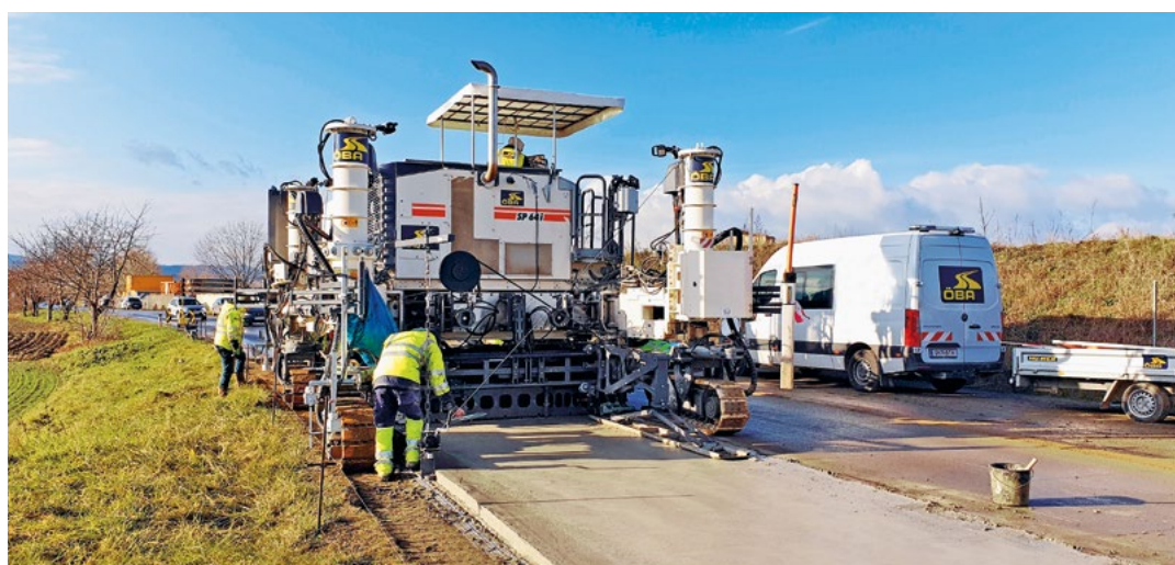
Mise en place du White Topping au finisseur
