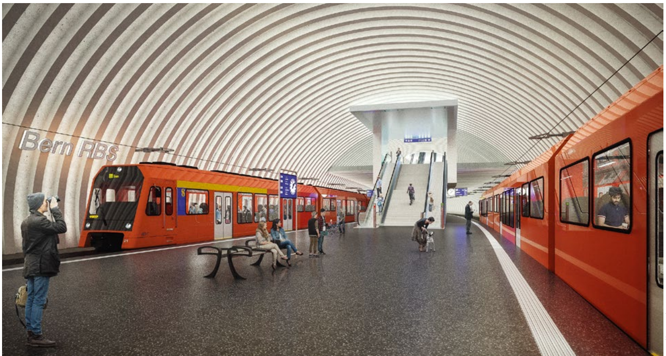
6 Bahnhofskavernen – Visualisierung des Gewölbes mit rippenartiger Struktur Station caverns – visualisation of the vault with rib-like structure
