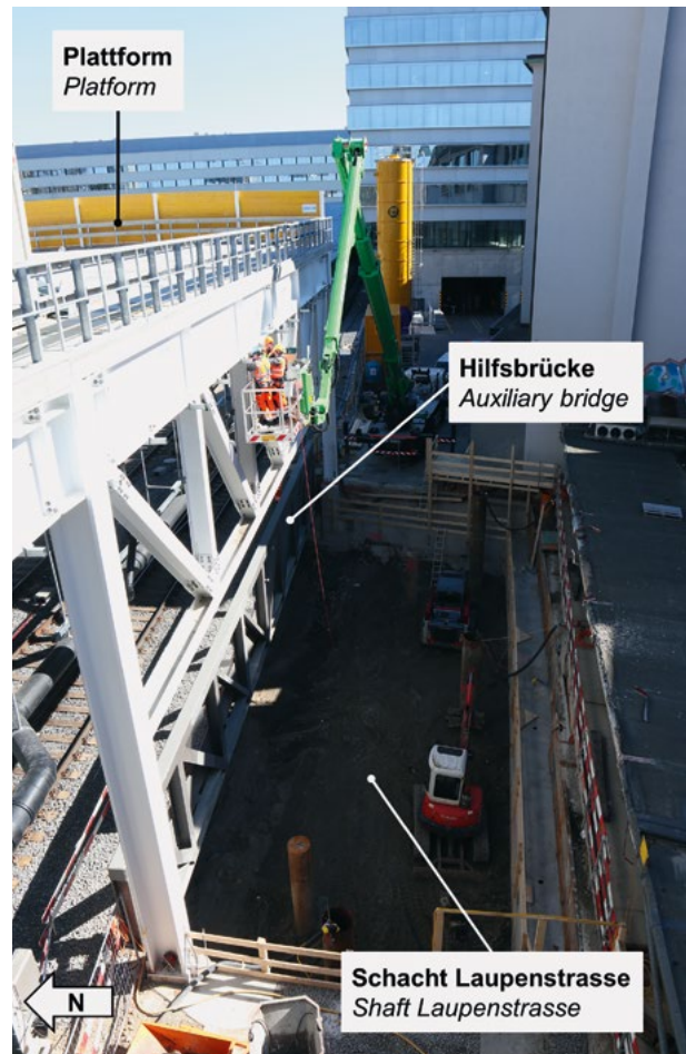
10 Schacht Laupenstrasse (Blickrichtung Ost) Laupenstrasse Shaft (looking east)
