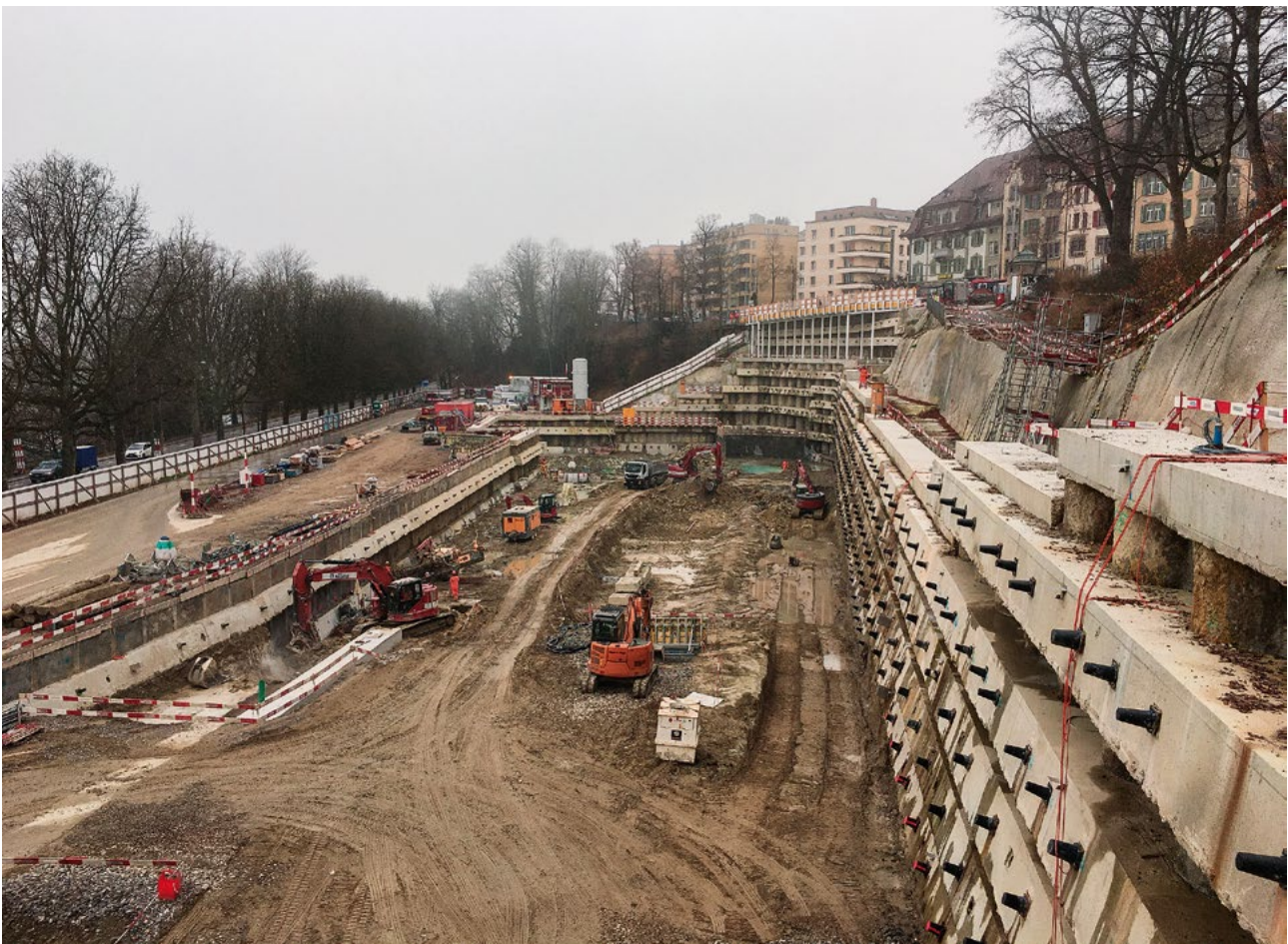
22 Wildpark – Baugrube (Blickrichtung Süd) Wildpark – construction trench (looking south)
