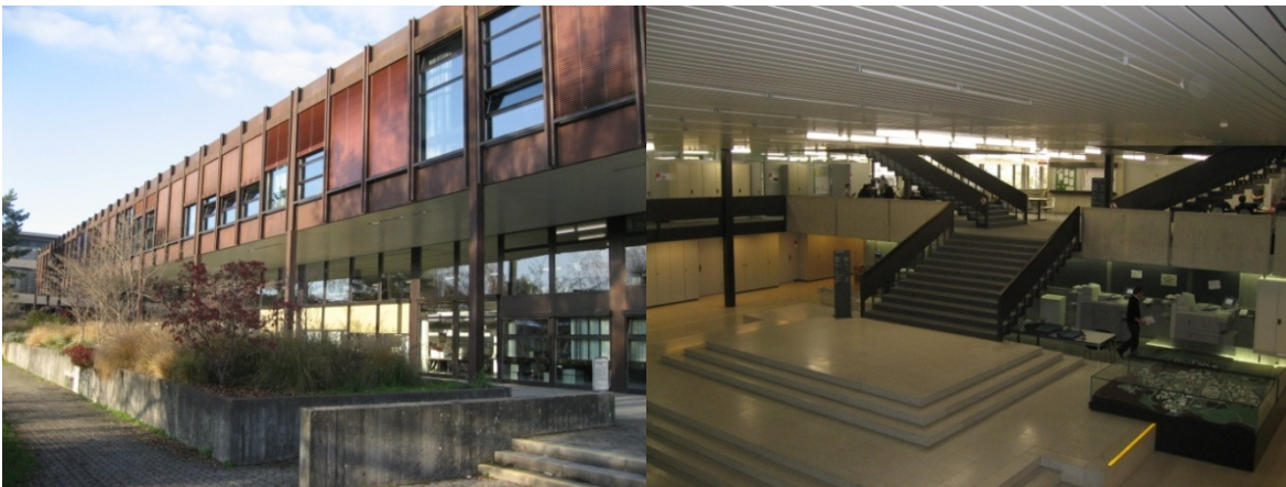
Abbildung 21: Fassadenansicht und Eingangsbereich Schulgebäude 1 an der Hochschule für Technik Rapperswil
