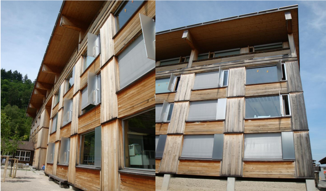
Abbildung 22: Fassadenansichten der Hochschule für Holzwirtschaft in Biel.
