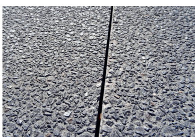
5 | Waschbeton Gesteinskörnung 8 mm (links) und mit Vorfrähschnitt (rechts). 5 | Béton lavé granulats 8 mm (à gauche) et avec découpe grossière (à droite).
