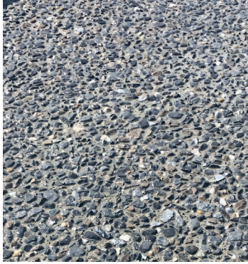
6 | Waschbeton GK 8 mm, Gesteine felsgebrochen, kubisch, Handeinbau. 6 | Béton lavé GK 8 mm, granulats extraits de la roche, cubiques, pose manuelle.
