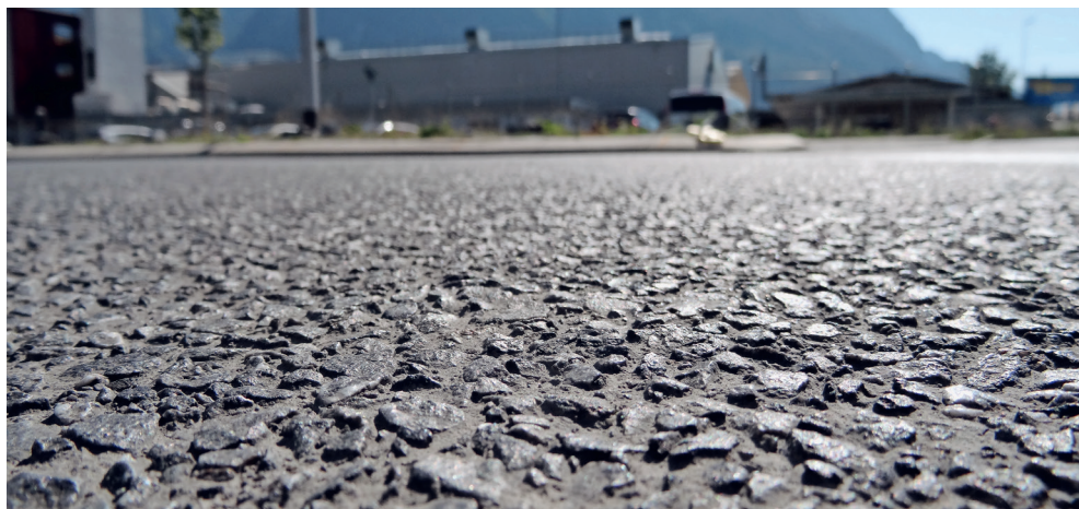
4 | Oberfläche Betonstrasse in Waschbetonbauweise.
