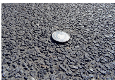
4 | Surface d'une route en béton lavé.
