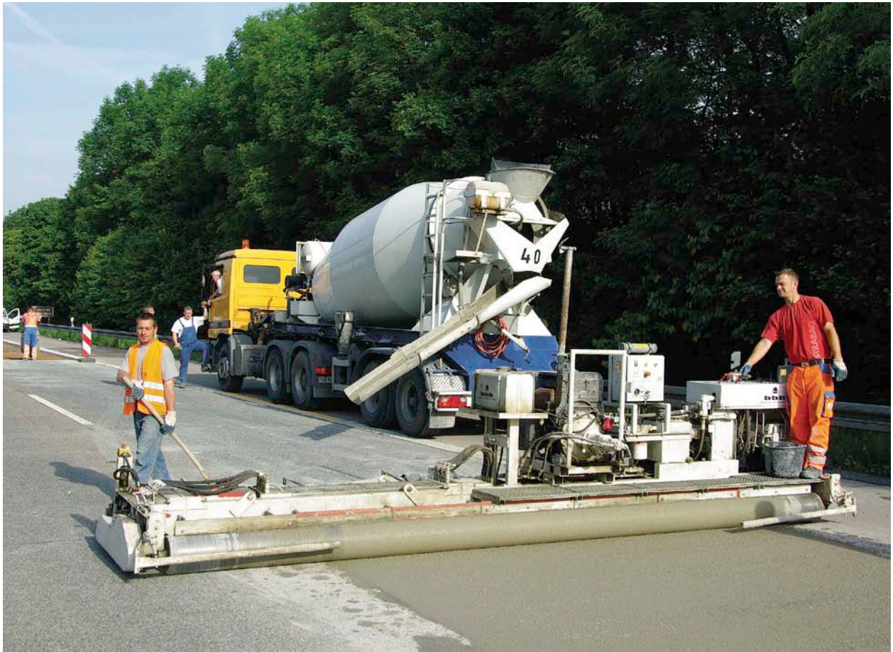
Fig. 2: Réparation d'un revêtement en béton (remplacement d'une dalle)
