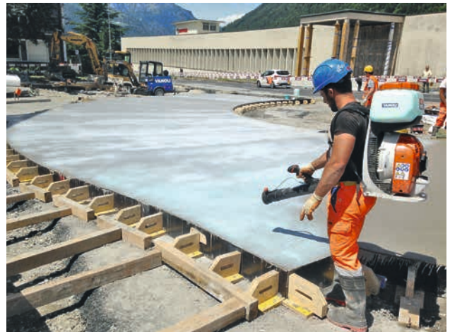
5. Épandage d'un adjuvant composite (retardateur et curing)
