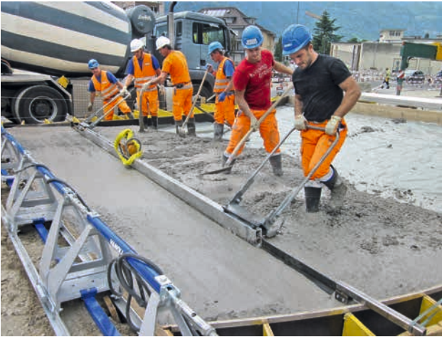
1. Mise en place du béton inférieur, ép. 20 cm
