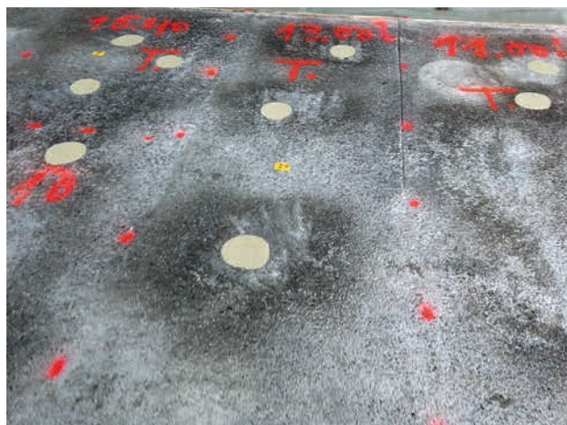
Surfaces d'essai soumises à des traitements différenciés
