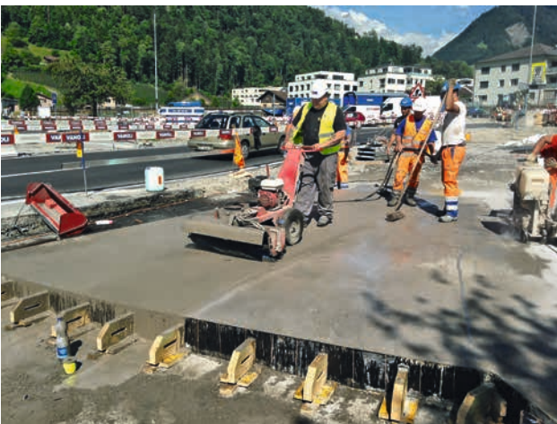
7. Brossage du béton en surface et nouvelle application d'un produit contre l'évaporation (curing)
