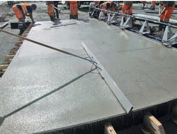
4. Égalisation et contrôle de la planéité
