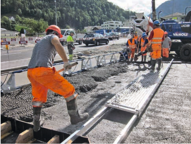
3. Mise en place du béton supérieur, ép. 6 cm
