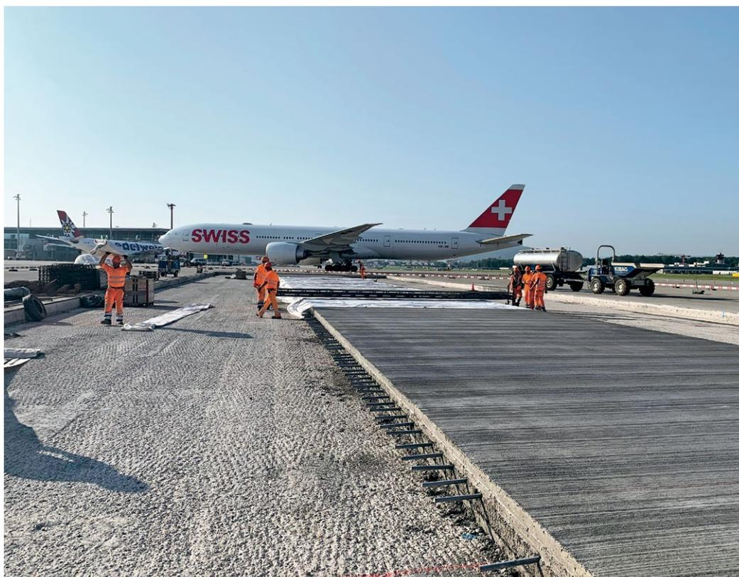
Cure de la bande libre mise en place (pose d'un produit de cure, puis recouvrement au moyen de non-tissés)
