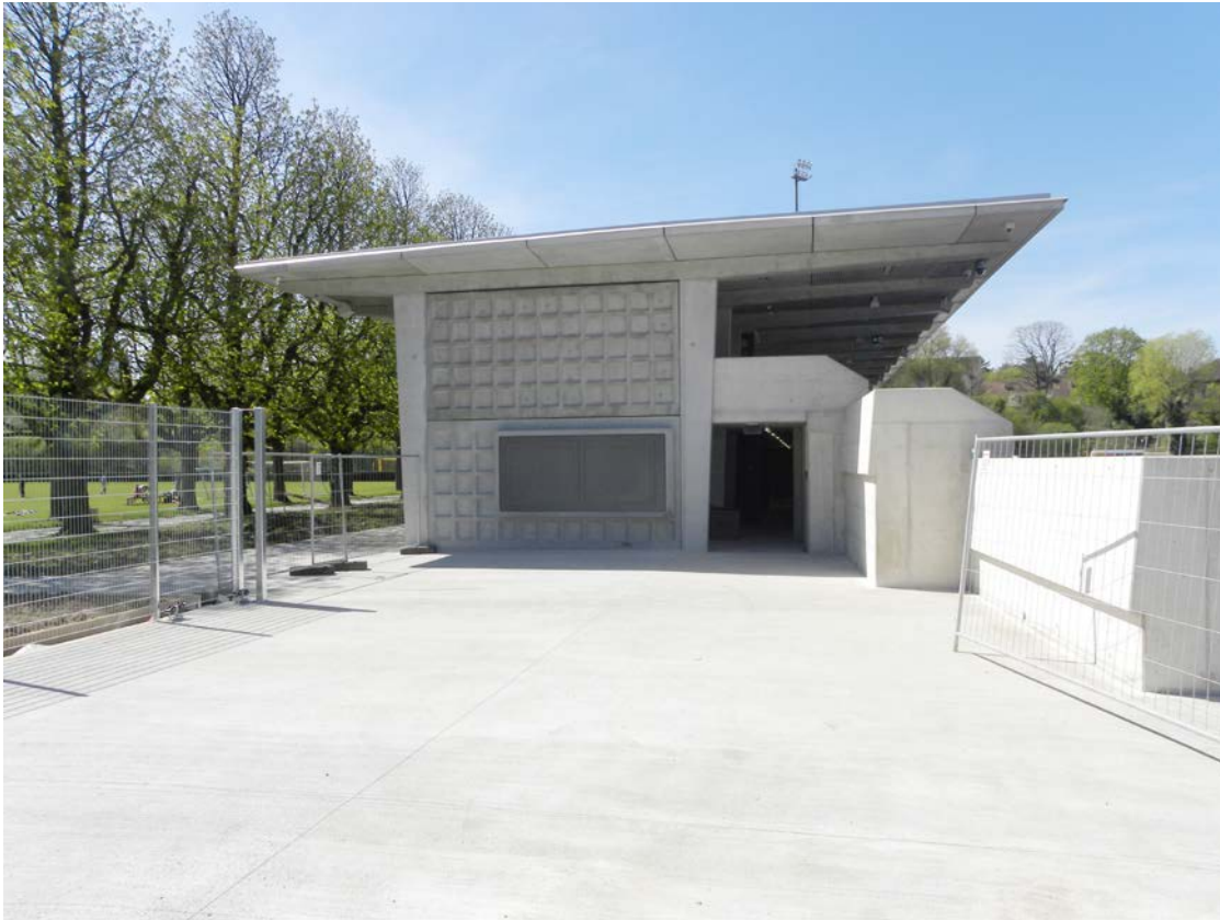
Tribünengebäude St.Jakob, Basel (Projekt von Netwerch)
