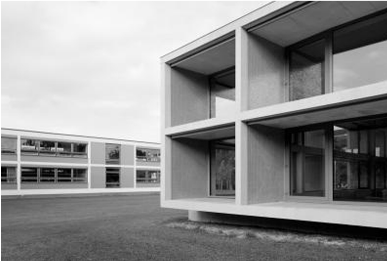
Foto Schulhaus Turnhalle
