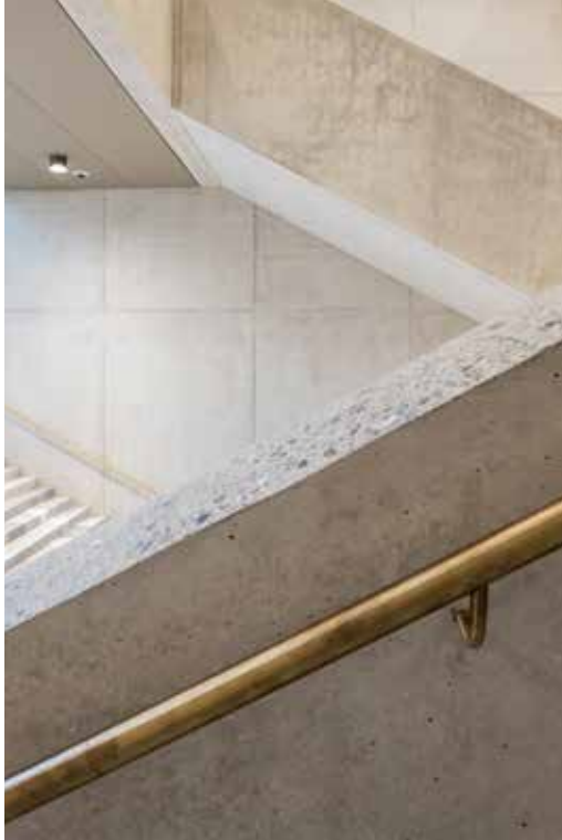
Treppenhaus: Geschliffene Betonbrüstungen, Handläufe aus Messing
