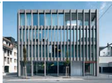
RAIFFEISENBANK AM RIGI KÜSSNACHT AM RIGI, 2010 Architekten LÜTOLF UND SCHEUNER, ARCHITEKTEN HTL SIA BSA GMBH, LUZERN Ingenieure PLÜSSMEYERPARTNER AG, LUZERN Unternehmungen VANOLI AG, IMMENSEE; GEBR. FRICK AG, SCHAAN (FL)
