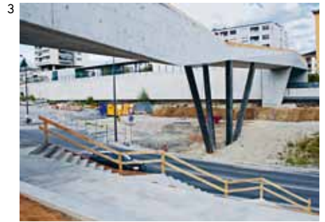
PASSERELLE DE LA SALLAZ LAUSANNE, 2012 Architectes 2B ARCHITECTES, LAUSANNE Ingénieurs MONOD-PIGUET & ASSOCIÉS INGÉNIEURS CONSEILS S.A., LAUSANNE Entreprise JPF CONSTRUCTION SA, LAUSANNE ET BULLE
