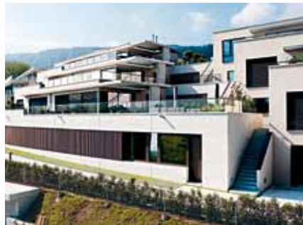
TERRASSENHÄUSER LAKE SIDE SCHINDELLEGI, 2012 Architekten DNSARCHITEKTEN GMBH, ZÜRICH Ingenieure HTB INGENIEURE + PLANER AG, PFÄFFIKON Unternehmung BUTTI BAUUNTERNEHMUNG AG, PFÄFFIKON
