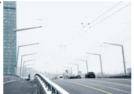
SANIERUNG HARDBRÜCKE ZÜRICH, 2011 Architekten BOESCH ARCHITEKTEN GMBH, ZÜRICH Ingenieure IG HARDBRÜCKE: FLÜCKIGER + BOSSHARD AG, ZÜRICH / EDY TOSCANO AG, ZÜRICH Unternehmung IMPLENIA BAU AG, ZÜRICH
