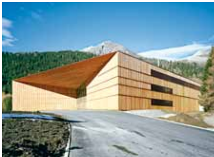
KONGRESSZENTRUM DAVOS, 2010 Architekten DEGELO ARCHITEKTEN BSA SIA AG, BASEL Ingenieure DR. SCHWARTZ CONSULTING AG, ZUG; DIAG DAVOSER INGENIEURE AG, DAVOS Unternehmungen TONEATTI AG, BILTEN; GEBR. VETSCH AG, KÜBLIS
