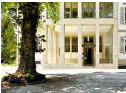
UM- UND ANBAU, INSTANDSETZUNG VILLA RAINHOF ZÜRICH, 2008 Architekten BOESCH ARCHITEKTEN GMBH, ZÜRICH Ingenieure APT INGENIEURE GMBH, ZÜRICH Unternehmung BREITENSTEIN AG, ZUG
