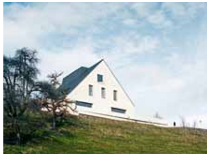
ERWEITERUNG PRIVATKLINIK HOHENEGG MEILEN, 2011 Architekten ROMERO & SCHAEFLE ARCHITEKTEN AG, ZÜRICH Ingénieurs DR. SCHWARTZ CONSULTING AG, ZUG Unternehmung BRUNNER STRUB + PARTNER AG, WETTINGEN
