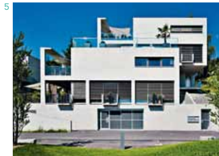
WOHNÜBERBAUUNG KIRCHBÜHL I MURI (AG), 2009 Architekten A4D ARCHITEKTEN AG, ZÜRICH Ingénieur WALTER NEUKOM, BONISWIL Unternehmung LEUTHARD BAU AG, MURI (AG)
