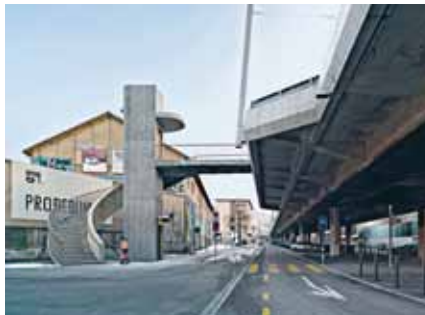
AUFGÄNGE AUF DIE HARDBRÜCKE ZÜRICH, 2011 Architekten BOESCH ARCHITEKTEN GMBH, ZÜRICH Ingenieure WALT + GALMARINI AG, ZÜRICH Unternehmung IMPLENIA BAU AG, ZÜRICH → S. 133
