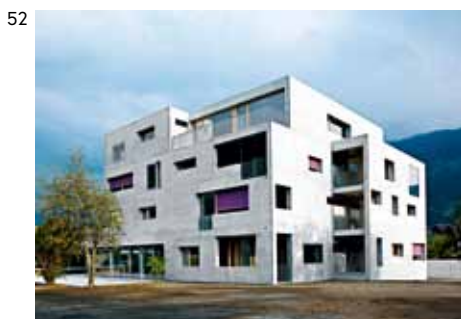
SENIORENZENTRUM BONGERT BONADUZ, 2011 Architekten FREI & EHRENSPERGER ARCHITEKTEN BSA, ZÜRICH Ingenieure WALTER BIELER AG, INGENIEURBÜRO FÜR HOLZKONSTRUKTIONEN, BONADUZ Unternehmung WOLF BAU AG, CHUR
