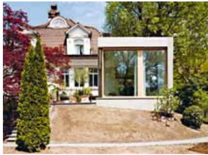
ANBAU VILLA BILL GÜMLIGEN, 2009 Architekten ARMON SEMADENI ARCHITEKTEN GMBH, ZÜRICH Ingenieure WEBER + BRÖNNIMANN AG, BERN Unternehmung CÄSAR BAY AG, KONOLFINGEN
