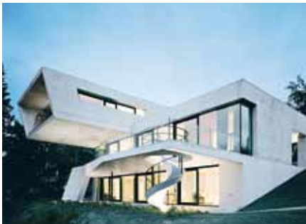
UNTERSEE – KRAFT UND SINN DER FORM ERMATINGEN, 2011 Architekten BIEHLER WEITH ASSOCIATED, KONSTANZ (D) Ingenieure BAUSTATIK RELING GMBH, SINGEN (D) Unternehmung WANZENRIED BAU AG, WEINFELDEN
