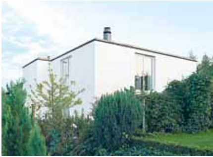
HAUS K+N WOLLERAU Architekten VALERIO OLGATI, FLIMS
