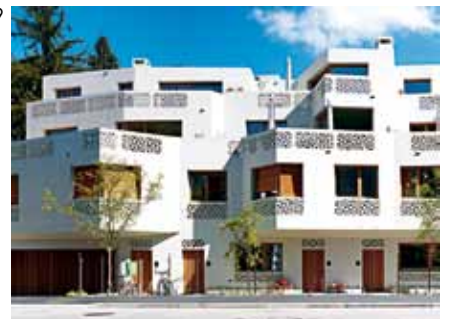
PATUMBAPARK, BAUFELD MÜHLEBACHSTRASSE ZÜRICH, 2012 Architekten MILLER & MARANTA, BASEL Ingenieure HENAUER GUGLER AG, ZÜRICH VORPROJEKT: CONZETT BRONZINI GARTMANN AG, CHUR Unternehmung GT BAU AG, DÜBENDORF
