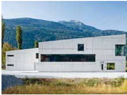
ATELIER- UND WOHNHAUS GAMPEL, 2012 Architekten VOMSATTEL + WAGNER ARCHITEKTEN, VISP Ingenieure VWI INGENIEURE AG, NATERS Unternehmung GEBR. ZENGAFFINEN AG, STEG
