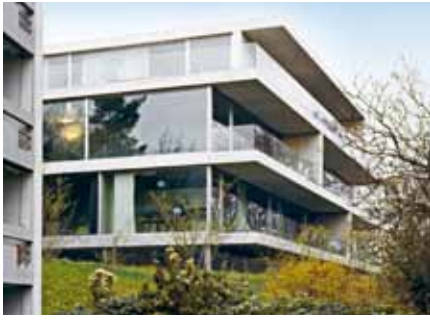
MEHRFAMILIENHAUS FORSTERSTRASSE ZÜRICH Architekten CHRISTIAN KEREZ, ZÜRICH
