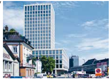
FACHHOCHSCHULZENTRUM ST. GALLEN, 2012 Architekten GIULIANI.HÖNGER AG, ZÜRICH Ingenieure DR. LÜCHINGER UND MEYER BAUINGENIEURE AG, ZÜRICH Unternehmung SAW SPANNBETONWERK AG, WIDNAU
