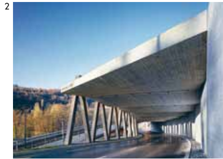
GALERIE DE LA SALLAZ LAUSANNE, 2011 Architectes 2B ARCHITECTES, LAUSANNE Ingénieurs JEAN-PAUL CRUCHON ET ASSOCIÉS S.A., LAUSANNE Entreprise CONSORTIUM ADV CONSTRUCTION SA, PENTHAZ / MARTIN & CO SA, ECHALLENS → S.133
