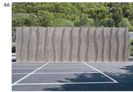
ANLIEFERUNG KULTURGÜTERSCHUTZANLAGE SAND CHUR, 2010 Architekten GREDIG WALSER DIPL. ARCHITEKTEN ETH FH SIA AG, CHUR Ingenieur IGNAZ CAMENISCH, DOMAT/EMS Unternehmung LAZZARINI AG, CHUR
