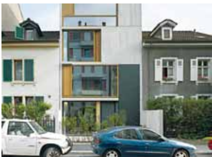
WOHNHAUS BLÄSIRING BASEL, 2012 Architekten BUCHNER BRÜNDLER ARCHITEKTEN, BASEL Ingenieure JÜRIG MERZ INGENIEURBÜRO, MAISPRACH Unternehmung KNECHT BAUUNTERNEHMUNG AG, MÜNCHENSTEIN
