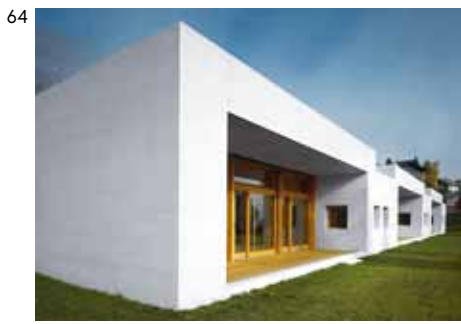
DREIFACHKINDERGARTEN SAMEDAN, 2012 Architekten GREDIG WALSER DIPL. ARCHITEKTEN ETH FH SIA AG, CHUR Ingenieure PLÁCIDO PÉREZ, DIPL. BAUINGENIEURE GMBH, BONADUZ Unternehmung OSCAR CHRISTOFFEL AG, ST. MORITZ
