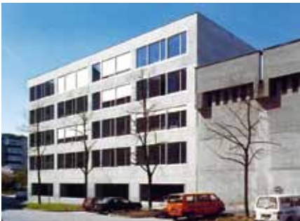
VOLTA-SCHULHAUS BASEL Architekten MILLER & MARANTA, BASEL
