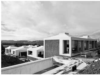
4 HOFHÄUSER ZUMIKON, 2012 Architekten THINK ARCHITECTURE AG, ZÜRICH Ingenieure FEDERER & PARTNER BAUINGENIEURE AG, ZÜRICH Unternehmung ROBERT SPLEISS AG, KÜSNACHT
