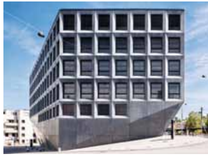
GESCHÄFTSHAUS AM BAHNHOFPLATZ LIESTAL, 2011 Architekten CHRIST & GANTENBEIN AG, BASEL Ingenieure SCHNETZER PUSKAS INGENIEURE AG, BASEL Unternehmungen SULSER AG, TRÜBBACH; WENK AG, NECKERTAL
