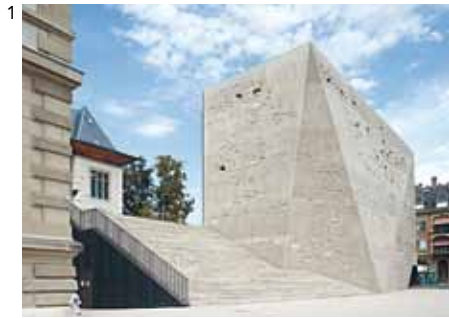
TITAN / KUBUS – ERWEITERUNG BERNISCHES HISTORISCHES MUSEUM BHM BERN, 2009 Architekten :MLZD, BIEL Ingenieure TSCHOPP INGENIEURE GMBH, BERN Unternehmung A. BILL AG, WABERN
