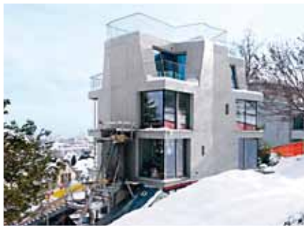
HAUS ALBISRIEDEN ZÜRICH, 2011 Architekten MICHAEL MEIER MARIUS HUG ARCHITEKTEN AG, ZÜRICH Ingenieure SYNAXIS AG, ZÜRICH Unternehmung RIEKE AG, ZÜRICH
