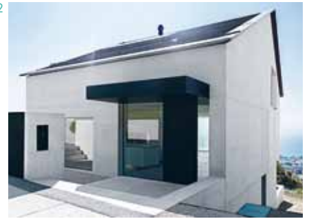
VILLA R MONT-SUR-ROLLE, 2012 Architecte COUNSON ARCHITECTES SÀRL, NYON Ingénieurs ESM-INGÉNÉRIE SA, GENÈVE Entreprise PERRIN FRÈRES, VICH
