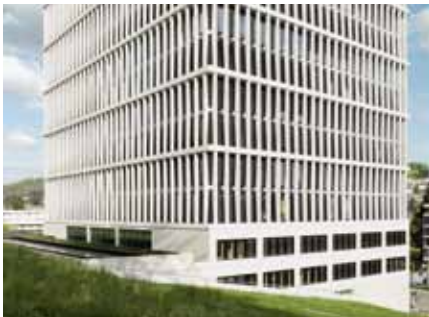
BUNDESVERWALTUNGSGERICHT ST. GALLEN, 2012 Architekten STAUFER & HASLER ARCHITEKTEN AG, FRAUENFELD Ingenieure CONZETT BRONZINI GARTMANN AG, CHUR; BÄNZIGER PARTNER AG, ST. GALLEN Unternehmung HRS REAL ESTATE AG, FRAUENFELD
