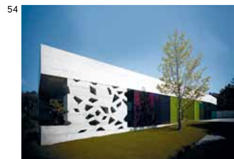
FRIEDHOFGEBÄUDE ERLENBACH, 2010 Architekten ANDREAS FUHRIMANN GABRIELLE HÄCHLER DIPL. ARCHITEKTEN ETH/BSA/SIA AG, ZÜRICH Ingenieur RETO BONOMO, RÜDLINGEN Unternehmung DOZZA BAU AG, KÜSNACHT ZH
