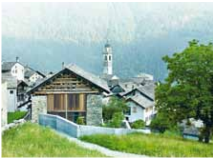
UMNUTZUNG EINES STALLS SOGLIO, 2009 Architekten RUINELLI & ASSOCIATI, ARCHITETTI SIA, SOGLIO Ingenieure TOSCANO AG, ST. MORITZ Unternehmung C. GANZONI AG, BAUGESCHÄFT, VICOSOPRANO
