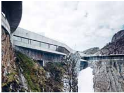
PANORAMAGALERIE PILATUS KULM ALPNACH, OW, 2011 Architekten NIKLAUS GRABER & CHRISTOPH STEIGER ARCHITEKTEN ETH/BSA/SIA GMBH, LUZERN Ingenieure DR. SCHWARTZ CONSULTING AG, ZUG Unternehmung ANLIKER AG BAUUNTERNEHMUNG, EMMENBRÜCKE
