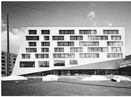
WOHN- UND GESCHÄFTSHAUS VOLTA ZENTRUM BASEL, 2010 Architekten BUCHNER BRÜNDLER ARCHITEKTEN, BASEL Ingenieure BEURRET INGENIEURE GMBH, BASEL Unternehmung IMPLENIA BAU AG, BASEL
