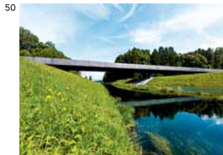
LE PONT NOIR SUR LE GRAND CANAL CHESSEL, 2012 Architectes FASTT SÄRL, ARCHITECTES ASSOCIÉS, LAUSANNE Ingénieurs CONUS & BIGNENS SA, LAUSANNE Entrepreneur CONSORTIUM FRUTIGER-WALO-PRADERLOSINGER- ATRA
