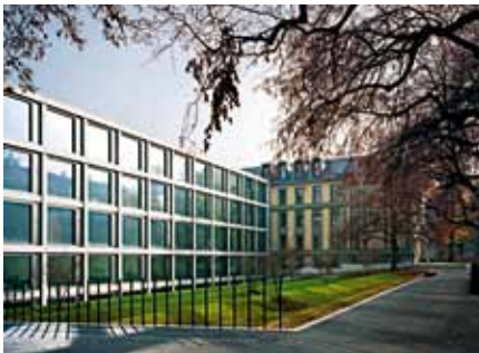
GEWERBLICH INDUSTRIELLE BERUFSSCHULE BERN (GIBB) VIKTORIA BERN, 2011 Architekten GRABER PULVER ARCHITEKTEN AG, BERN/ZÜRICH Ingenieure MARCHAND & PARTNER AG, BERN Unternehmung ELEMENTWERK BRUN AG, EMMEN
