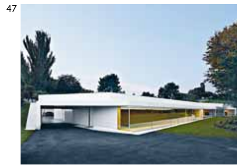
AGRANDISSEMENT D'UNE VILLA VANDEUVRES, 2011 Architecte PIERRE-ALAIN DUPRAZ ARCHITECTE ETS FAS, GENÈVE Ingénieur URNER & ASSOCIÉS SA, GENÈVE Entreprise D'ORLANDO SA, GENÈVE
