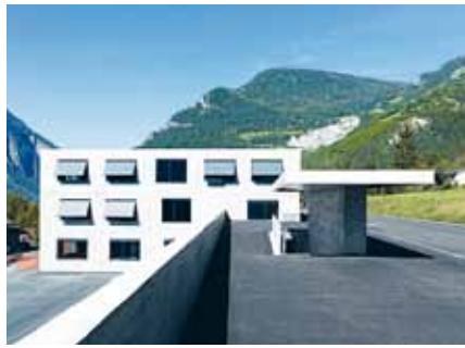
ÉCOLE PRIMAIRE VOLLÈGES, 2010 Architectes SAVIOZ FABRIZZI ARCHITECTES FAS, SION; MEYER ARCHITECTURE SÀRL, SION Ingénieurs BUREAU D'INGÉNIEURS CIVILS KURMANN ET CRETTON SA, MONTHEY Entreprise POLLI ET CIE SA, MARTIGNY
