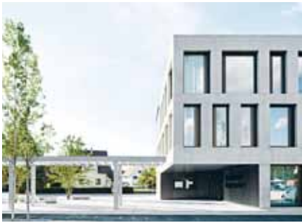
GEMEINDEHAUS REGENSDORF, 2011 Architekten PHALT ARCHITEKTEN AG, ZÜRICH Ingénieurs SCHNETZER PUSKAS INGENIEURE AG, ZÜRICH Unternehmung K. EICHER BAUUNTERNEHMUNG AG, REGENSDORF
