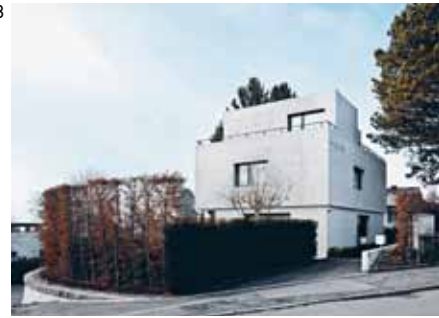
EINFAMILIENHAUS ERLENBACH, 2010 Architekten SPILLMANN ECHSLE ARCHITEKTEN AG, ZÜRICH Ingenieure HAAG + PARTNER INGENIEURE GMBH, KÜSNACHT Unternehmung MÜLLER FORCH AG, MAUR
