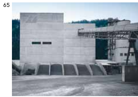
ERSATZ KIESWERK MONTALTA SCHNAUS, 2010 Architekten GREDIG WALSER DIPL. ARCHITEKTEN ETH FH SIA AG, CHUR; CASUTT WYRSCH ZWICKY AG, CHUR Ingenieure CASUTT WYRSCH ZWICKY AG, CHUR Unternehmungen ARGE CAPREZ BAU AG, ILANZ / CASUTT AG, FALERA
