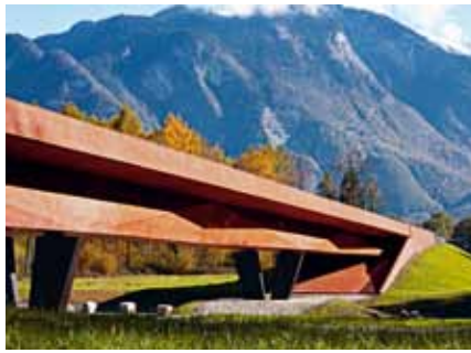
PONT SUR LE RHÔNE LES EVOUETTES, 2012 Architectes MEIER & ASSOCIÉS ARCHITECTES SA, GENÈVE Ingénieurs CONUS & BIGNENS SA, LAUSANNE Entreprise CONSORTIUM FRUTIGER-WALO-PRADERLOSINGER- ATRA
