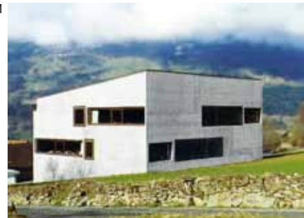
SCHULHAUS PASPELS Architekten VALERIO OLGATI, ZÜRICH
