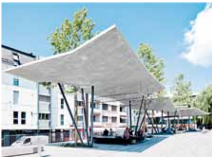
LE COUVERT DE LA PLACE DU MARCHÉ RENNES, 2011 Architectes LOCALARCHITECTURE SÀRL, LAUSANNE Ingénieurs BG INGÉNIEURS CONSEILS SA, LAUSANNE Entreprise JAQUET SA, RENNAZ → S.133
