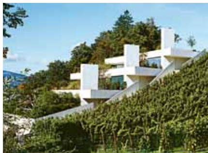
DREI TERRASSENHÄUSER LUZERN, 2011 Architekten MARQUES AG, LUZERN Ingenieure BLESSHES AG, LUZERN Unternehmung GEBR. AMMAN & CO. AG, LUZERN
