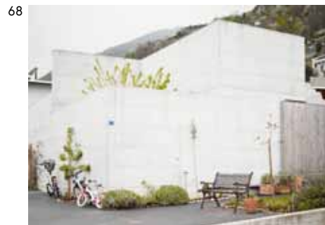
CASA FORINI MONTE CARASSO, 2010 Architetti GUIDOTTI ARCHITETTI, MONTE CARASSO Ingegneri STUDIO D'INGEGNERIA M. KÜNG E G. VILLA, BIASCA Impresa G.R. COSTRUZIONI SAGL, MONTE CARASSO → S.132
