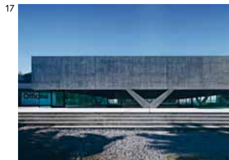
PALESTRA DOPPIA CPC CHIASSO, 2011 Architetti BASERGA MOZZETTI ARCHITETTI, MURALTO Ingegneri INGEGNERI PEDRAZZINI GUIDOTTI SAGL, LUGANO Impresa MAFLEDIL SA, OSOGNA
