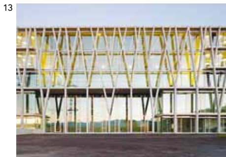
CYCLE D'ORIENTATION DE DRIZE CAROUGE (GE), 2010 Architectes B + W ARCHITECTURE SA, LAUSANNE EN ASSOCIATION AVEC TEKHNE SA, LAUSANNE Ingénieurs INGENI SA LAUSANNE, LAUSANNE Entreprises CONSORTIUM BELLONI SA / INDUNI & CIE SA, CAROUGE (GE); PRELCO PRÉFA- BRICATION D'ÉLÉMENTS DE CONSTRUCTION SA, SATIGNY ET SACAC AG, LENZBURG
