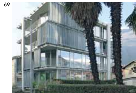
PROGETTO 1077 BELLINZONA, 2012 Architetti GUIDOTTI ARCHITETTI, MONTE CARASSO Ingegneri INGEGNERI PEDRAZZINI GUIDOTTI SAGL, LUGANO Impresa G.R. COSTRUZIONI SAGL, MONTE CARASSO
