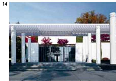
AGRANDISSEMENT DU MUSÉE OLYMPIQUE LAUSANNE, 2013 Architectes B + W ARCHITECTURE SA, LAUSANNE EN ASSOCIATION AVEC TEKHNE SA, LAUSANNE Ingénieurs MUTTONI ET FERNANDEZ INGÉNIEURS CONSEILS SA, ECUBLENS (VD) Entreprise MFP PRÉFABRICATION SA, MARIN
