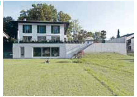
UMBAU UND ANBAU WOHNHAUS MURI BEI BERN, 2012 Architekten ORGASTRIT ARCHITEKTEN GMBH, ZÜRICH Ingénieurs STATOLITH AG, INGENIEURBÜRO FÜR HOCH- UND TIEFBAU, ZUCHWIL Unternehmung MARTI AG, BERN
