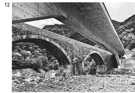
NUOVO PONTE DI FRASCO SULLA VERZASCA VAL VERZASCA, 2009 Architetti MICHELE ARNABOLDI ARCHITETTI SAGL, LOCARNO Ingegneri GRIGNOLI MUTTONI PARTNER STUDIO D'INGEGNERIA SA, LUGANO Impresa -
