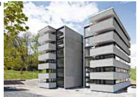
WOHNHÄUSER LINDENSTEIG LUZERN, 2012 Architekten GRASER ARCHITEKTEN AG, ZÜRICH Ingenieure SCHUBIGER AG, BAUINGENIEURE LUZERN Unternehmungen SCHMID BAUUNTERNEHMUNG AG, EBikon; ELEMENT AG, VELTHEIM (AG)
