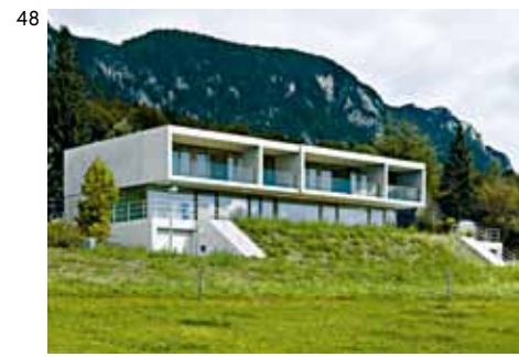
DOPPELVILLA AM JURASÜDFUSS OBERDORF (SO), 2012 Architekten ERN+HEINZL GESELLSCHAFT VON ARCHITEKTEN MBH, SOLOTHURN Ingenieure WAM PLANER UND INGENIEURE AG, SOLOTHURN Unternehmung STÜSSI BETONVORFABRIKATION AG, DÄLLIKON
