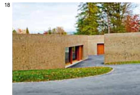
EXTENSION DE L'HERBIER ET CRÉATION D'ESPACES D'ACCUEIL DU PUBLIC GENÈVE, 2012 Architectes BASSICARELLA ARCHITECTES, GENÈVE Ingénieurs FIECHTER INGÉNIEURIE SA, CHÊNE-BOURG Entreprise DUNOYER CONSTRUCTION SA, PLAN-LES-OUATES
