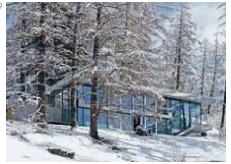
NEUBAU WALDHAUS TGAPLOTTAS ALVANEU DORF, 2011 Architekten CAVIGELLI DIPL. ARCHITEKTEN ETH/SIA AG, DOMAT/EMS Ingenieure PÖYRY INFRA AG, CHUR Unternehmung BAUUNTERNEHMUNG CENTORAME AG, SCHMITTEN (GR)
