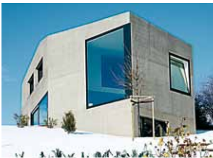
VILLA DIND LA TOUR-DE-PEILZ, 2012 Architectes LINK ARCHITECTES SA, LA TOUR-DE-PEILZ Ingénieurs BOSSON INGÉNIEURS SA, SIVIRIEZ Entreprise FELLI CONSTRUCTION SA, VEVEY
