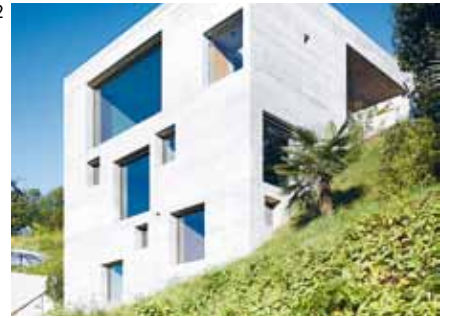
CASA S. ABBONDIO, 2012 Architetti WESPI DE MEURON ROMEO ARCHITETTI SA, CAVIANO Ingegneri ANASTASI INGEGNERIA, LOCARNO Impresa MERLINI & FERRARI SA, MINUSIO
