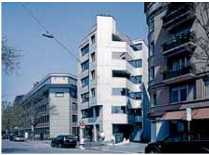
MEHRFAMILIENHAUS RÖNTGENSTRASSE 10 ZÜRICH, 2010 Architekten ANDREAS FUHRIMANN GABRIELLE HÄCHLER DIPL. ARCHITEKTEN ETH/BSA/SIA AG, ZÜRICH Ingenieure ADALI ENGINEERING GMBH, WALLISELEN Unternehmung BALTENSPERGER AG, SEUZACH
