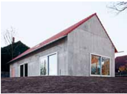
HAUS KÜNTEN, 2011 Architekten MICHAEL MEIER MARIUS HUG ARCHITEKTEN AG, ZÜRICH Ingenieure CONZETT BRONZINI GARTMANN AG, CHUR Unternehmung A. STENZ AG, NIEDERWIL
