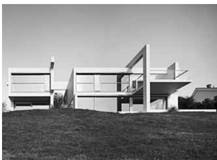
WOHNHAUS HERTENSTEIN WEGGIS, 2012 Architekten BUCHNER BRÜNDLER ARCHITEKTEN, BASEL Ingenieure SCHNETZER PUSKAS INGENIEURE AG, BASEL Unternehmung CATENAZZI BAU AG, WEGGIS
