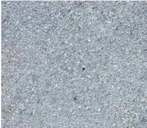
Illustration 13: surface de béton «bouchardée»
