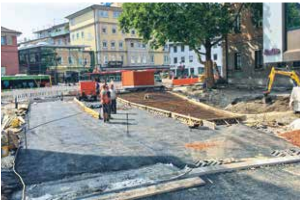
Illustration 2: infrastructure (couche de base en asphalte)
