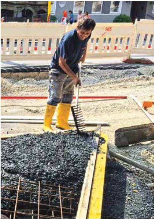
Illustration 8: bétonnage
