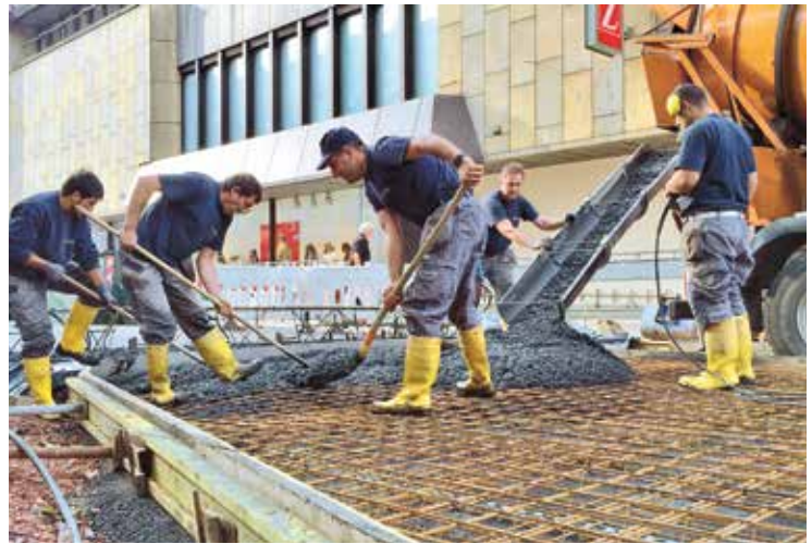
Illustration 9: bétonnage
