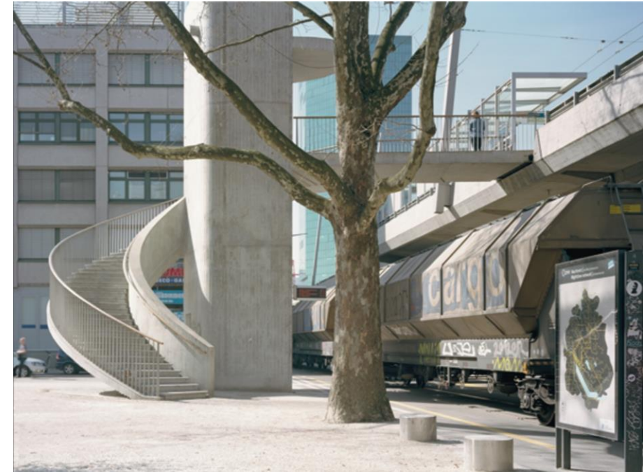
Treppenaufgang auf die Hardbrücke (Hochstrasse mit Busspur) Zürich
