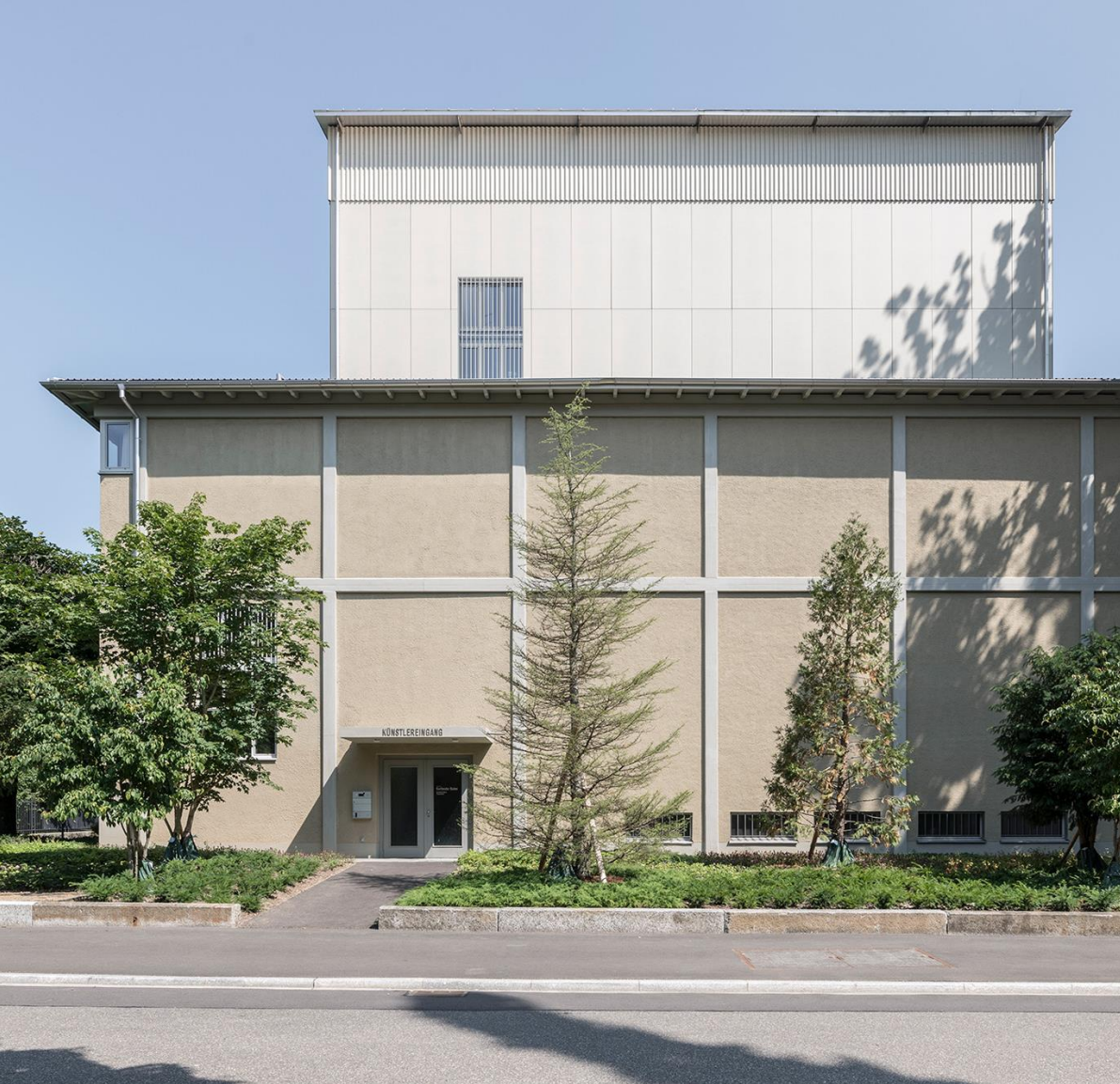
Westfassade - die Nahtstelle zwischen dem Bestand und dem Anbau ist 'unsichtbar'
