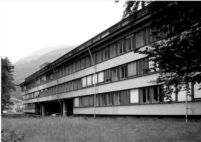
Verwaltungsgebäude Eternit Niederurnen, HMS Instandsetzung 1997 - 2005
