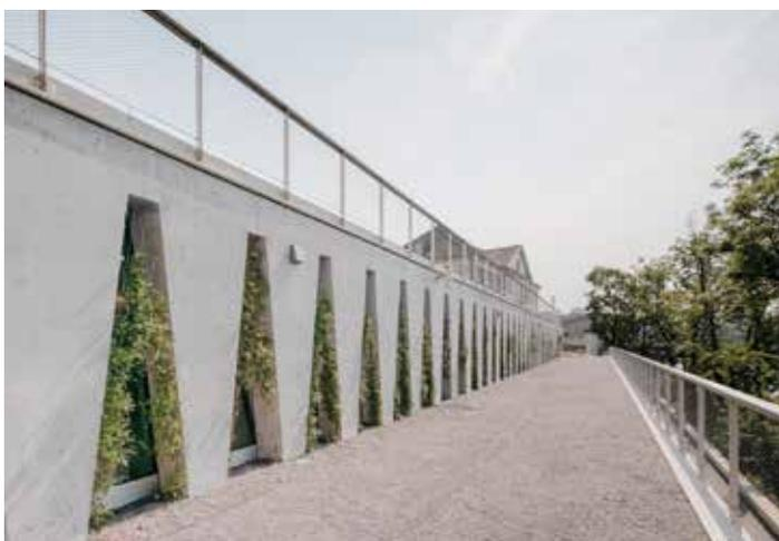
Die 65 Zentimeter starke Außenwand des Tanzhauses wurde aus rund 250 Kubikmetern Liapor-Isolationsbeton errichtet – so die landestypische
