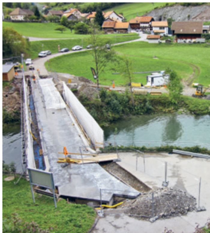
Fig. 8 Coup d'œil sur le pont de Montbovon durant les travaux de renforcement
