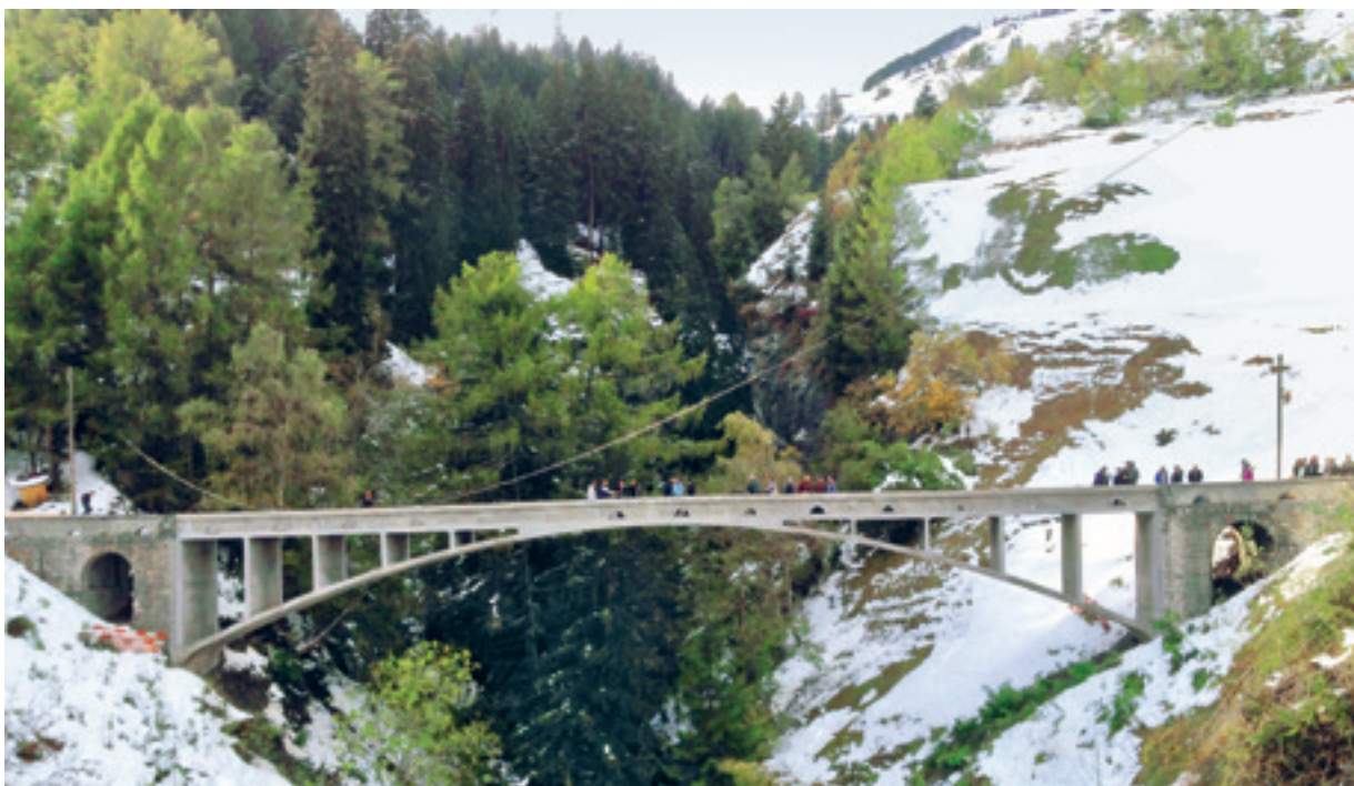
Fig. 7 Le pont après sa réhabilitation en douceur
