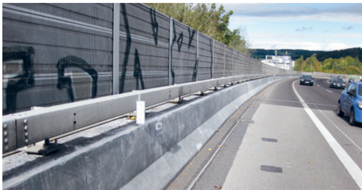
Fig. 5 Parapet réhabilité au moyen d'une couche de BFUP
