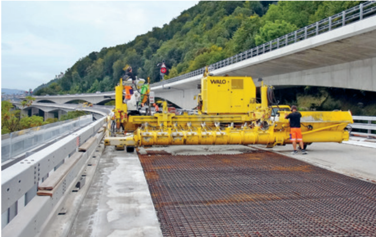
Fig. 14 Mise en place mécanique du BFUP au moyen d'une finisseuse adaptée spécialement à ce travail
