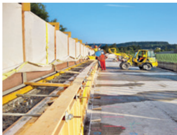
Fig. 4 Coffrage pour la couche de protection
