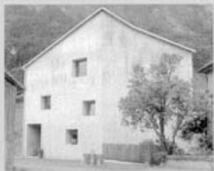
Dämmbeton an Ort gegossen
