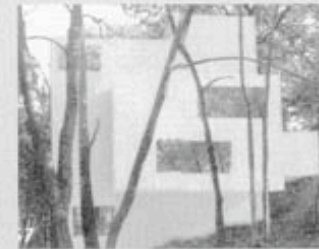
Zweischalenmauerwerk in Ortbeton
