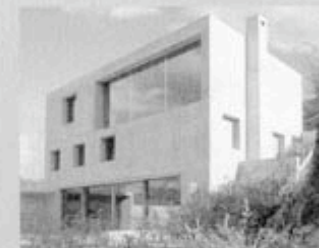
Dämmbeton an Ort gegossen
