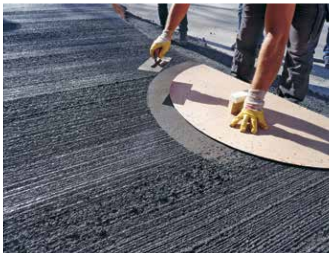
Finition de surface dans la zone des bordures.
