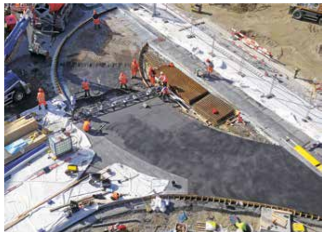
Dressage de la surface au moyen d'une règle vibrante.
