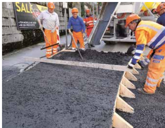
Mise en œuvre du béton teinté en noir dans la masse.
