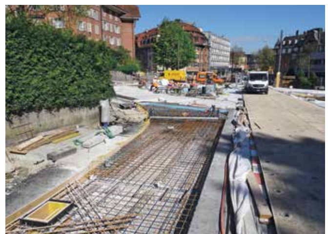
Bétonnage de la troisième étape.
