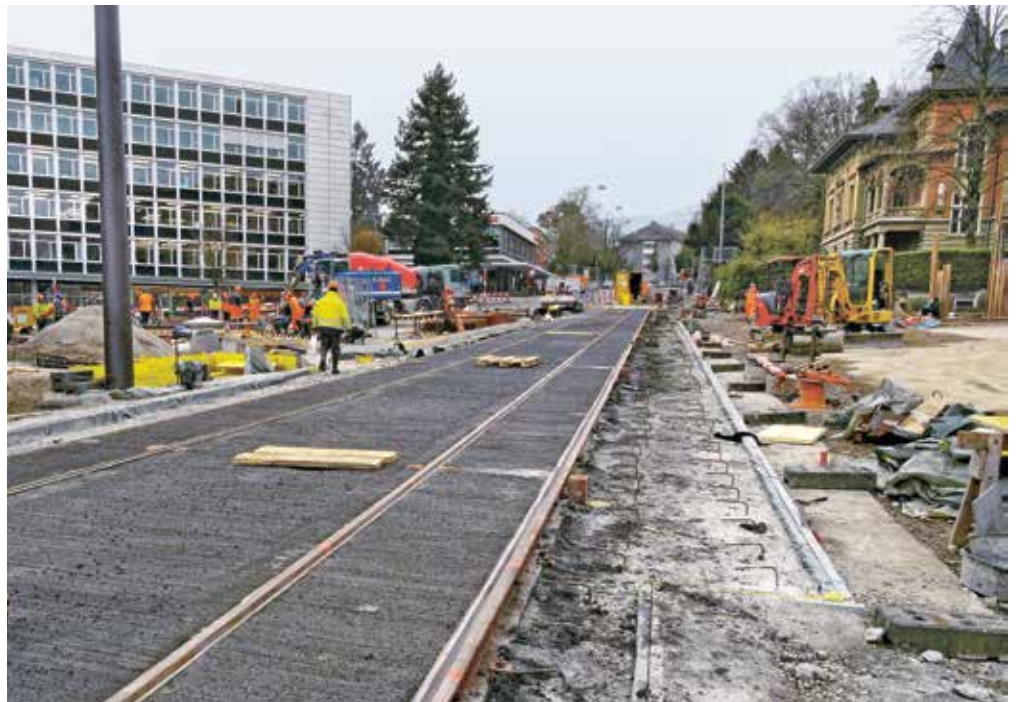
Tracé achevé du tramway avant le bétonnage du giratoire.
