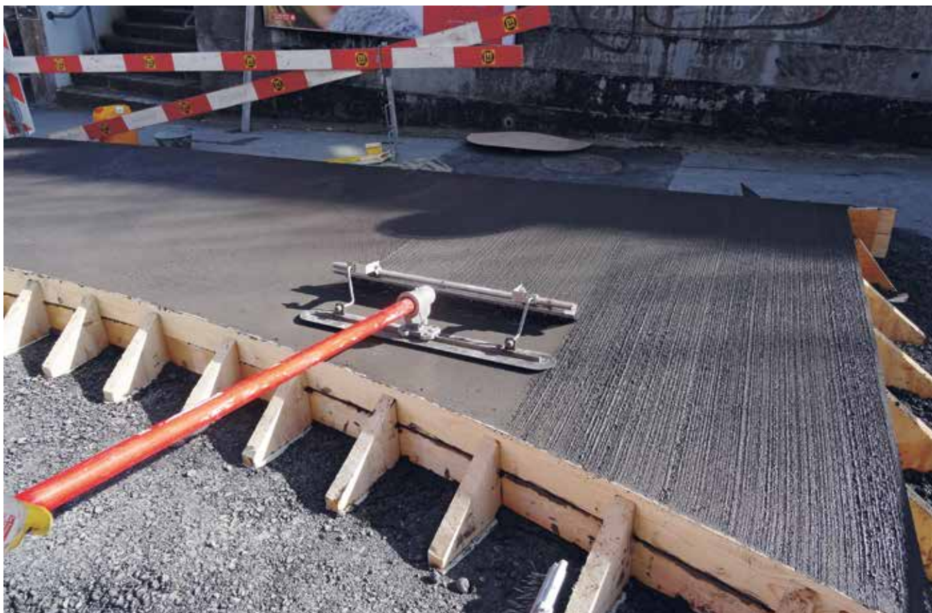
Rugosification de la surface au balai (en haut) et îlot central avec bordures de finition en pierres collées (à droite).
