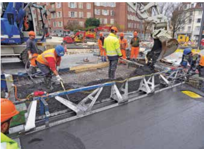
Mise en œuvre du béton de la seconde étape.
