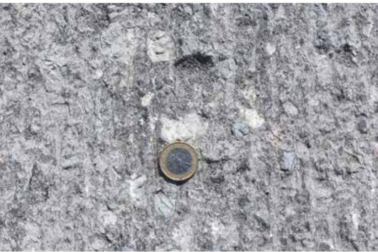
Illustration 3: Décapage par fraisage de la couche supérieure en asphalte
