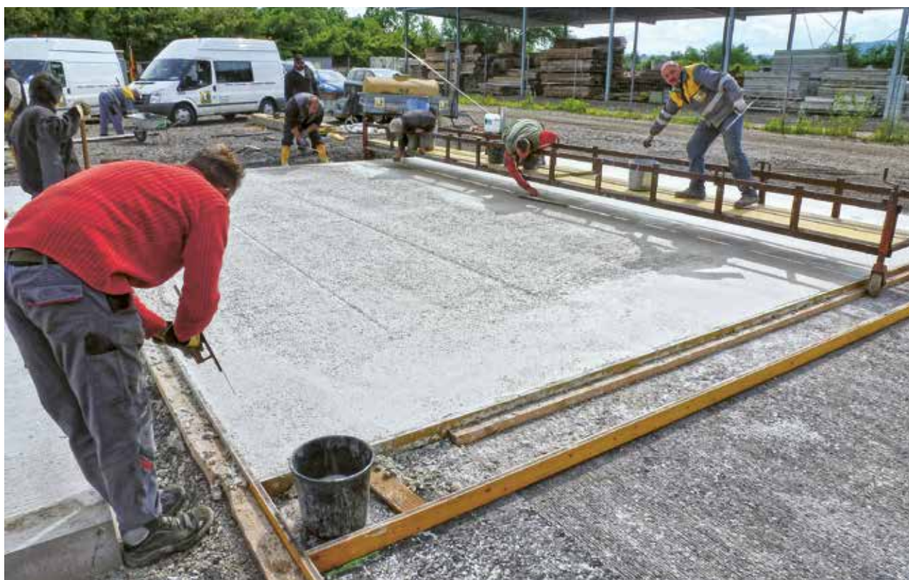
Illustration 5: Mise en place du béton et structuration de la surface (coup de balai)
