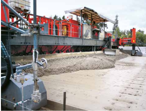
Fig. 6 : Mise en place du béton supérieur au moyen de la finisseuse à coffrage glissant
