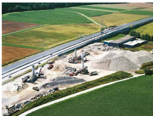
Fig. 3 : Installation mobile de lavage-criblage avec stockage intermédiaire
