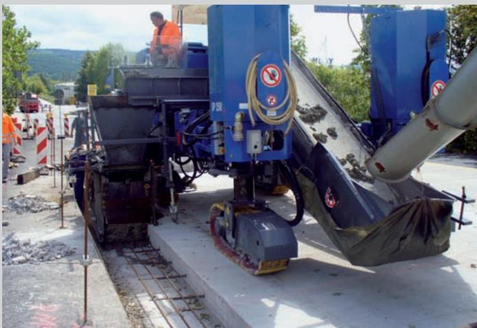
Mise en place de la bordure avec caniveau à Bad Sobernheim au moyen d'une finisseuse à coffrage glissant photo: J. Gisdepski
