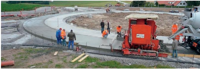
Construction d'un giratoire à Stapfenedt, Haute-Autriche, au moyen d'une finisseuse à coffrage glissant
