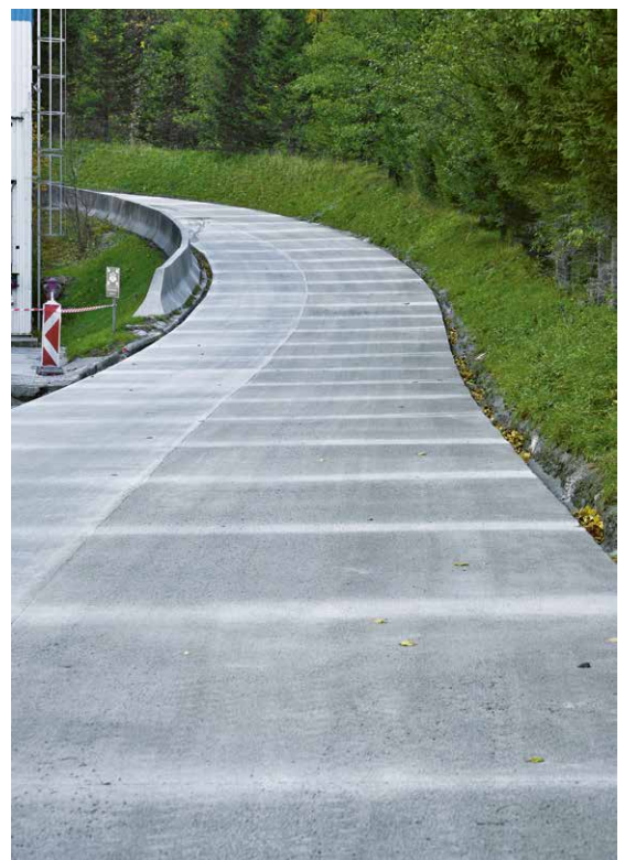
Illustration 19 : mise en place manuelle du béton dans la zone d'élargissement du virage
