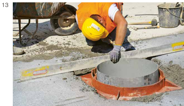
Illustration 11 : dégagement du regard Illustration 12 : insertion de la pièce de raccordement et calage de l'anneau de protection Illustration 13 : mise à niveau de la pièce de raccordement Illustration 14 : lissage manuel de la surface de béton Illustration 15 : balayage de la surface en béton lavé Illustration 16 : route en béton achevée
