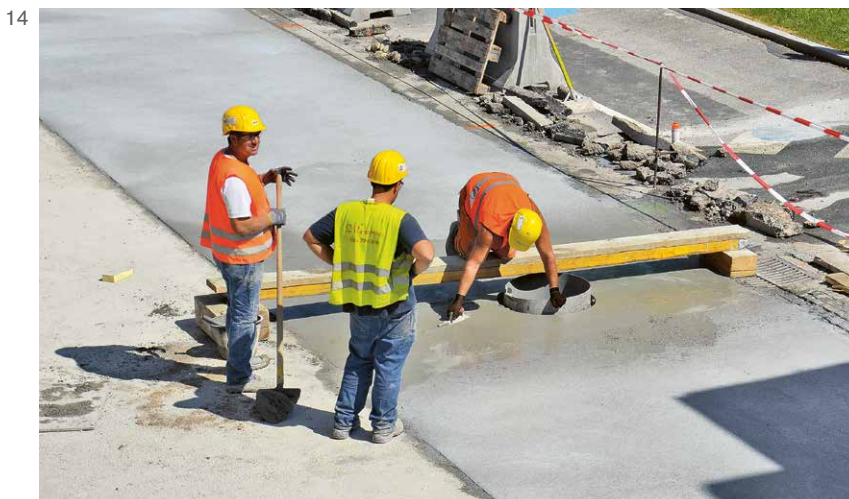
Illustration 11 : dégagement du regard Illustration 12 : insertion de la pièce de raccordement et calage de l'anneau de protection Illustration 13 : mise à niveau de la pièce de raccordement Illustration 14 : lissage manuel de la surface de béton Illustration 15 : balayage de la surface en béton lavé Illustration 16 : route en béton achevée
