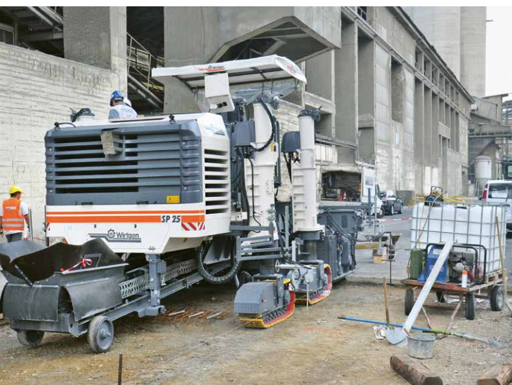
Illustration 3 : gestion du trafic sur une voie Illustration 4 : finisseur à coffrage glissant
