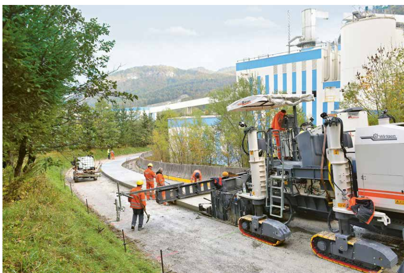
Illustration 17 : mise en place sur terrain en pente
