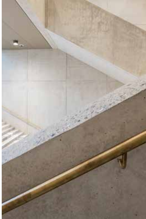
Treppenhaus: Geschliffene Betonbrüstungen, Handläufe aus Messing
