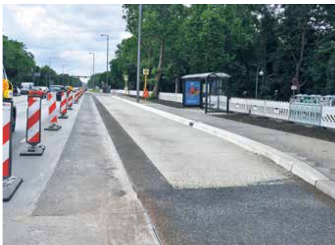
Fertiggestellte Bushaltestelle mit Fertigteilen
