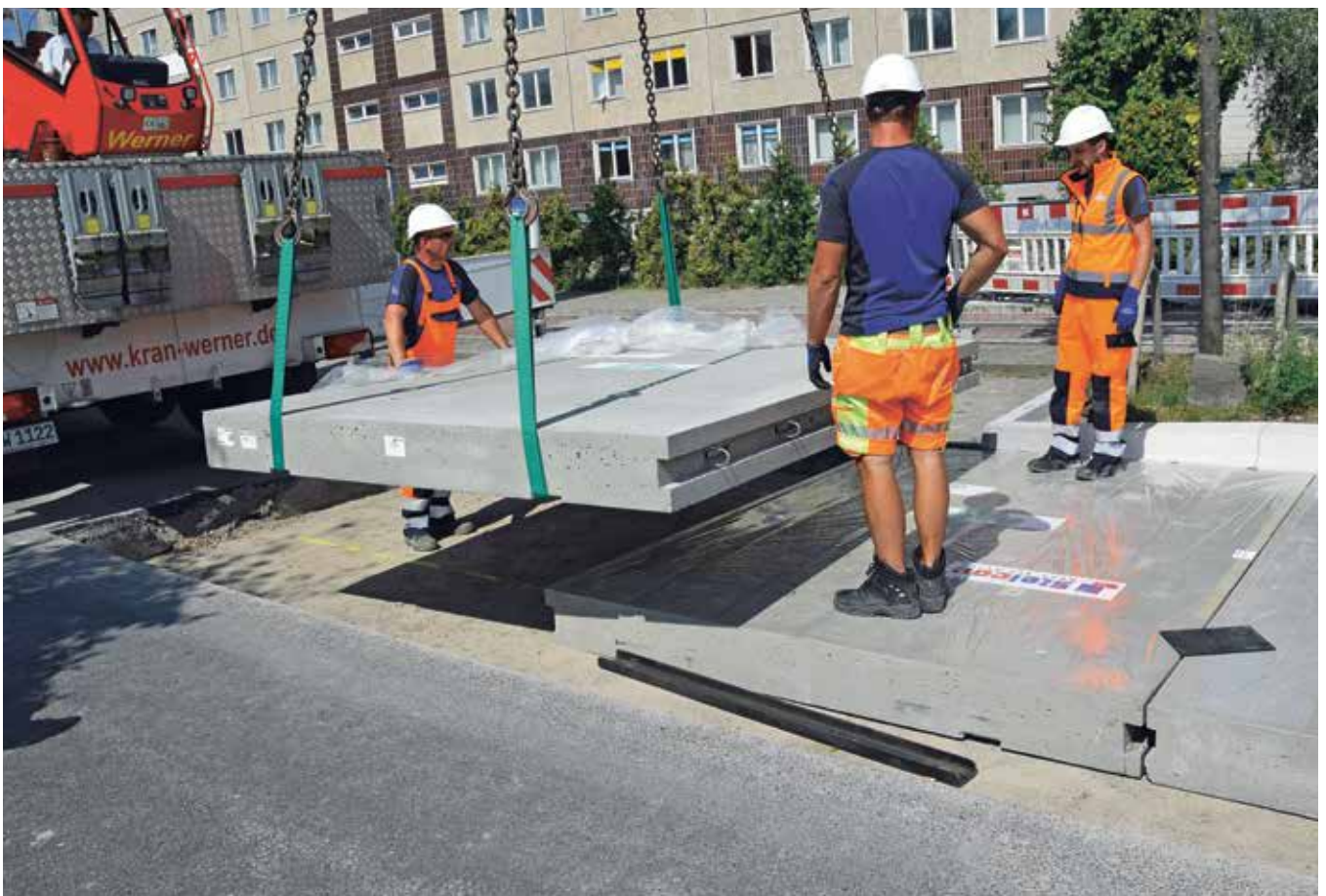
Alternative Verlegetechnik mittels Hochleistungsgurtbändern
