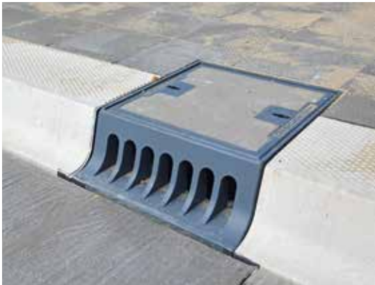
Exakter Einbau des Fertigteils am Kasseler Bord mit Seitenablauf
