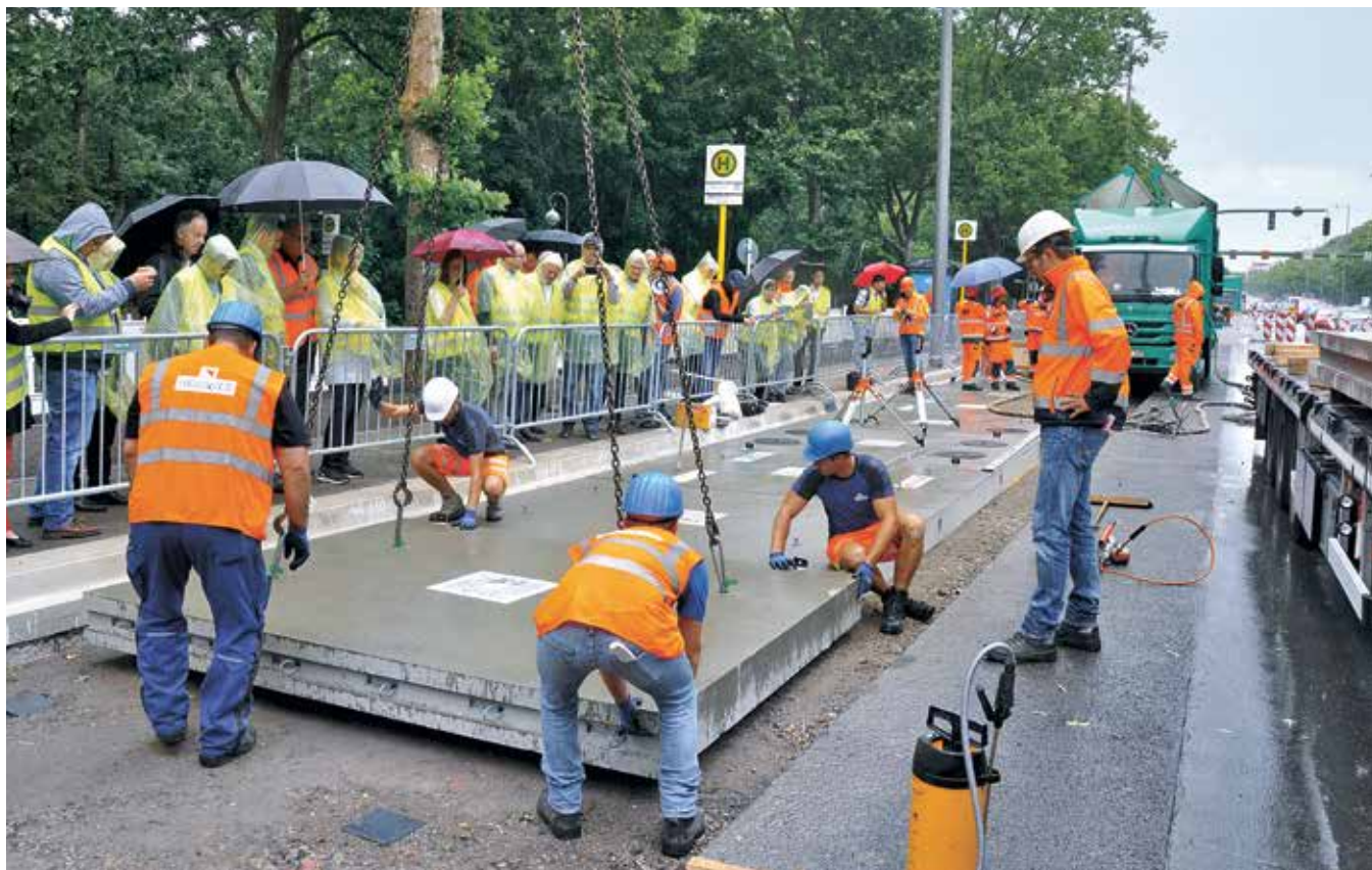
Besucher des Internationalen Betonstraßensymposiums beim Fertigteilereinbau
