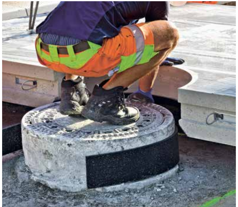
Verlegung des ersten Fertigteils am Schacht
