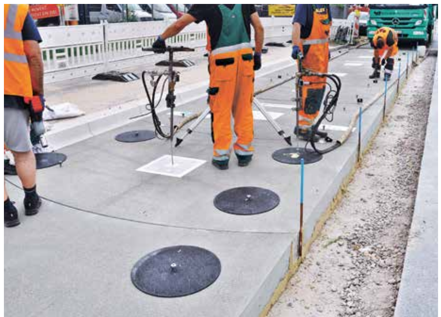
Einbringen des Silikatharzes nach dem Verlegen und Ausrichten der Fertigteile
