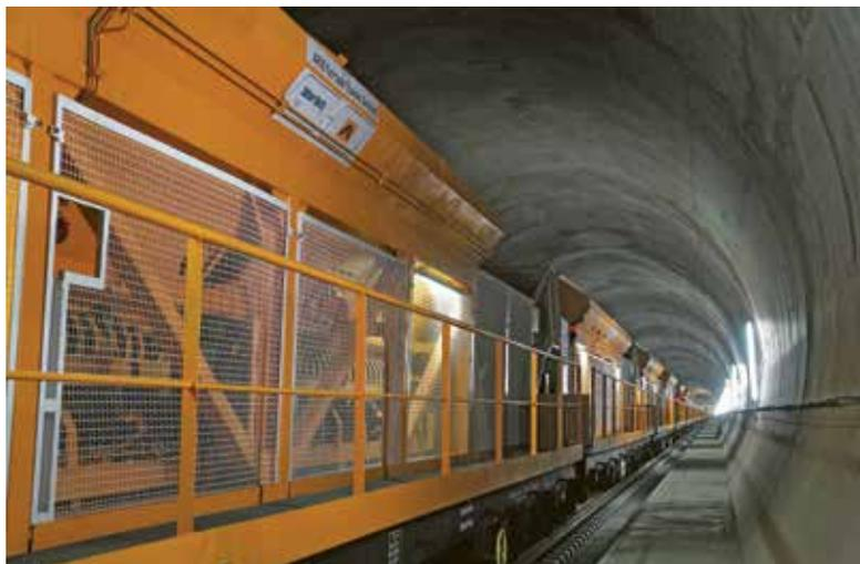
Illustration 11 : les wagons du train de bétonnage transportant les agrégats © AFTTG
