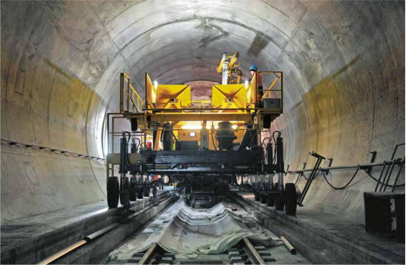
Illustration 13 : le transporteur de béton circule sur la banquette ©TTG
