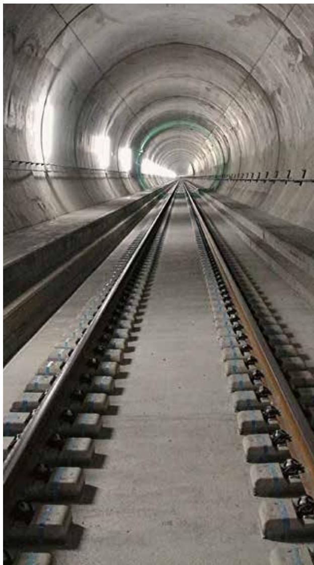
Illustration 2 : voie sur dalle de béton achevée dans le tronçon Faido-Bodio ouest © TTG
