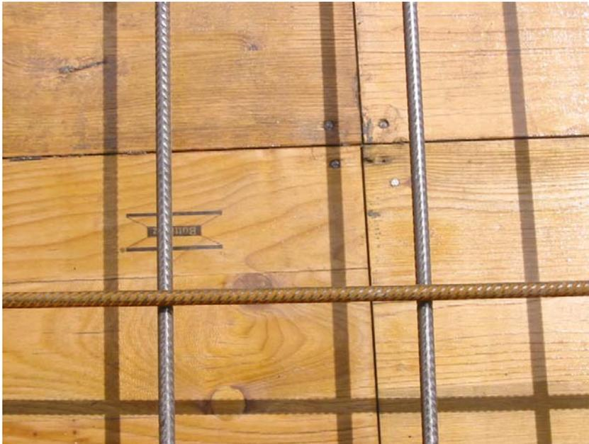
Die Oberflächenqualität an Schalungsstössen hängt – wie bei allen mehrfach eingesetzten Schalungen – von Qualität und Zustand des verwendeten Materials sowie der fachgerechten Anwendung und Reinigung der Element ab.
