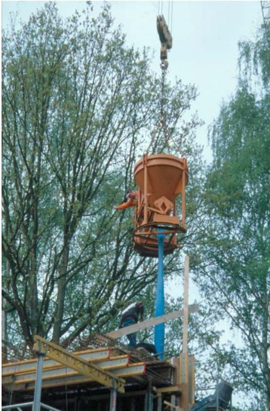
Richtiges Einbringen ist die Voraussetzung für Sichtbeton
