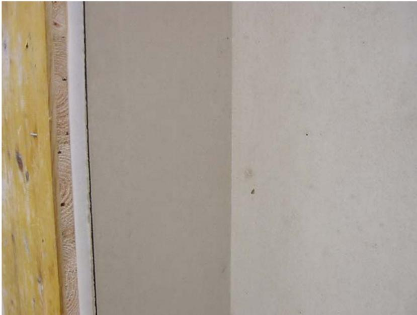
Abdichtungen verbessern die Dichtigkeit der Schalhaut- und der Schalungsstößen
