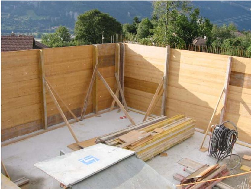
Ankerstellen sind nach gestalterischen und konstruktiven Kriterien planbar
