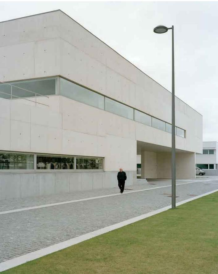
– A partir du rez-de-chaussée bas, le bâtiment semble se détacher et s'étirer vers l'avant. Le dessin soigné des joints et des attaches du coffrage dans le béton d'un blanc éclatant souligne cette impression. La structure statique, avec des profilés en aciers pris dans le béton, est hybride.
