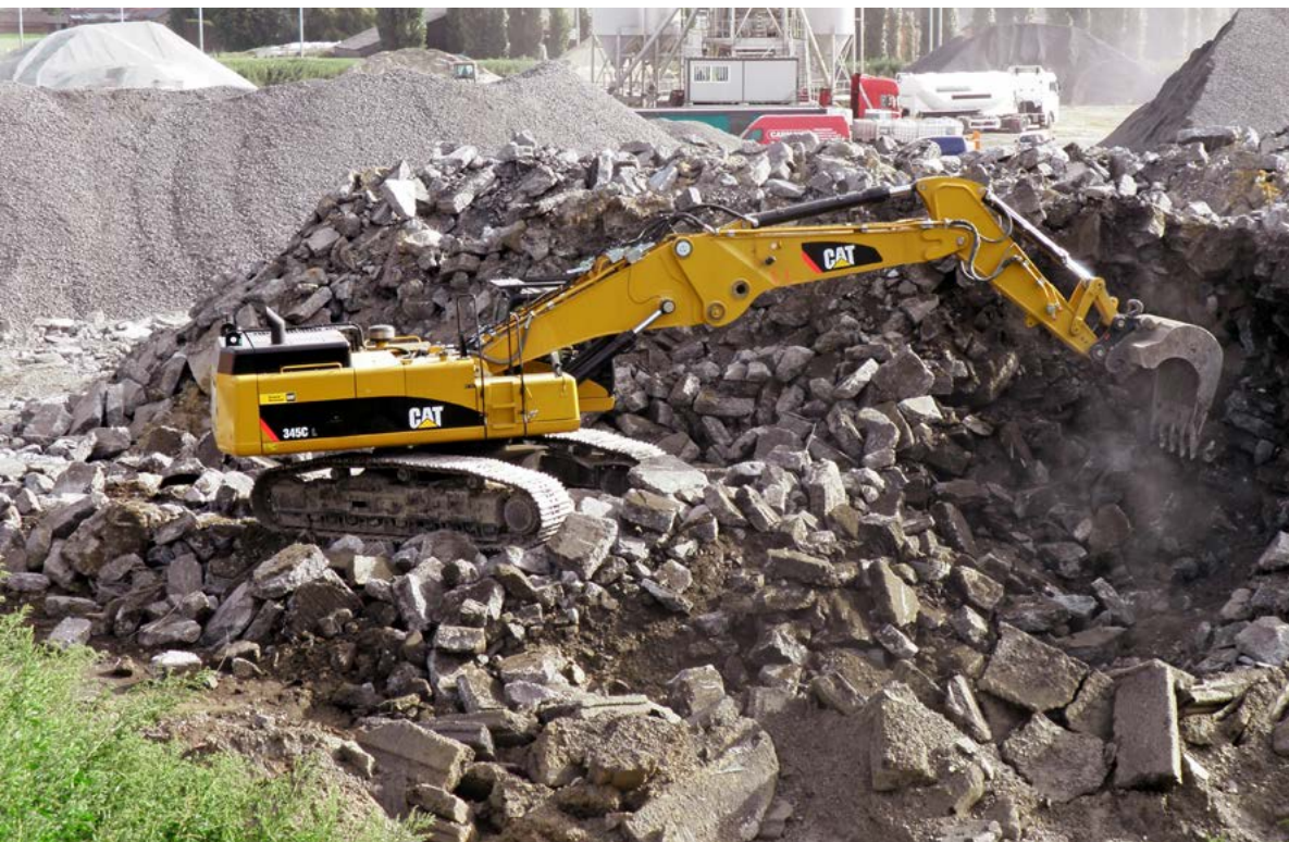
Le concassage intelligent du béton donne des granulats recyclés de meilleure qualité et permet de réutiliser la pâte de ciment recyclée.
