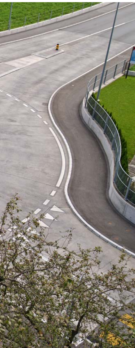
Premier rond-point de Suisse en béton lavé permettant une meilleure adhérence et un amortissement du bruit plus important à Altdorf, canton d'Uri.
