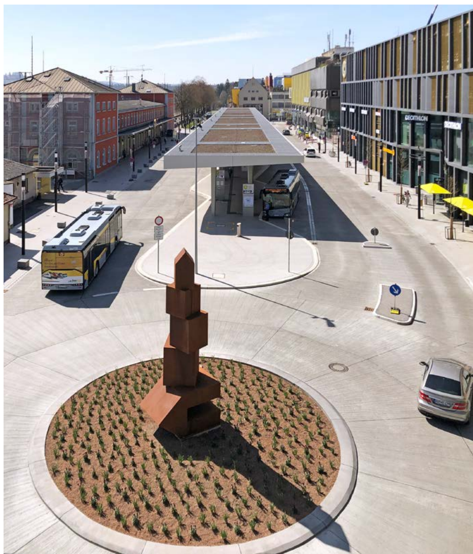
Un exemple de mise en œuvre durable du béton dans la construction moderne de routes : la gare de bus très fréquentée de Singen (DE). La mise en œuvre de béton y garantit une durée de vie d'au moins 30 ans.
