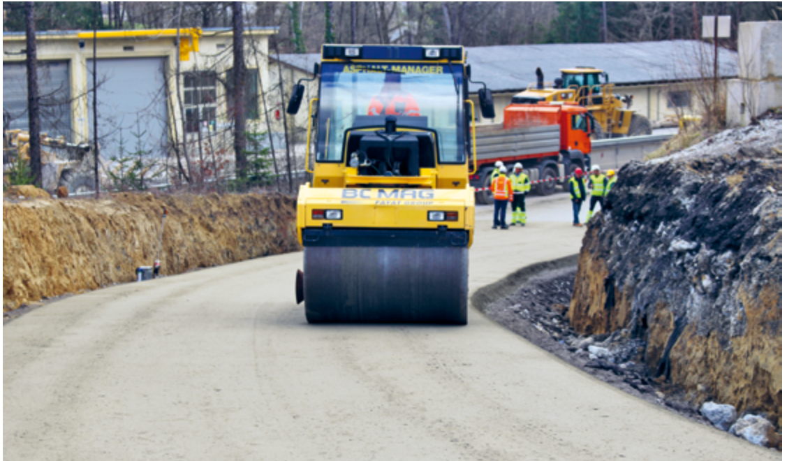
Le béton compacté peut aussi être posé dans les virages et sur les sections à pente.
