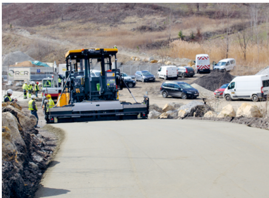
Mise en place et compactage du béton dans différents cas de figure
