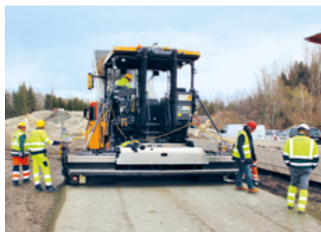
Mise en place du béton à l'aide du finisseur sur chenilles Volvo : la largeur de pose correspond à la largeur de l'engin.
