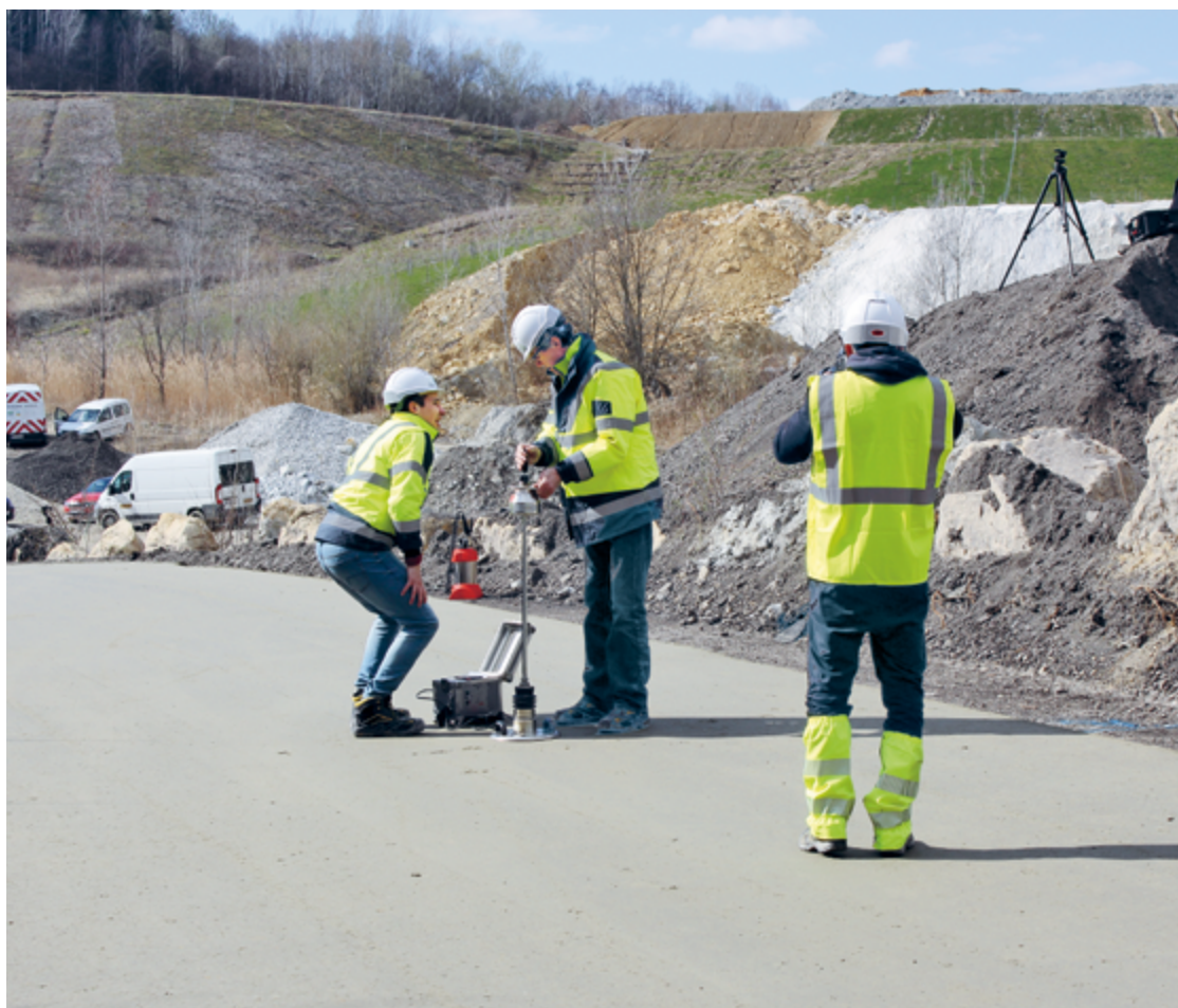
La mise en œuvre est contrôlée par des tests parallèles sur le béton frais, mais aussi par une vérification du compactage assortie d'une mesure non destructive de la masse volumique apparente au moyen d'un densimètre Troxler et d'un déflectomètre à masse tombante léger.
