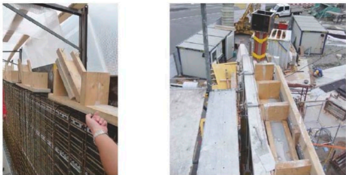
Baustellenprozess – Konterschaltung
