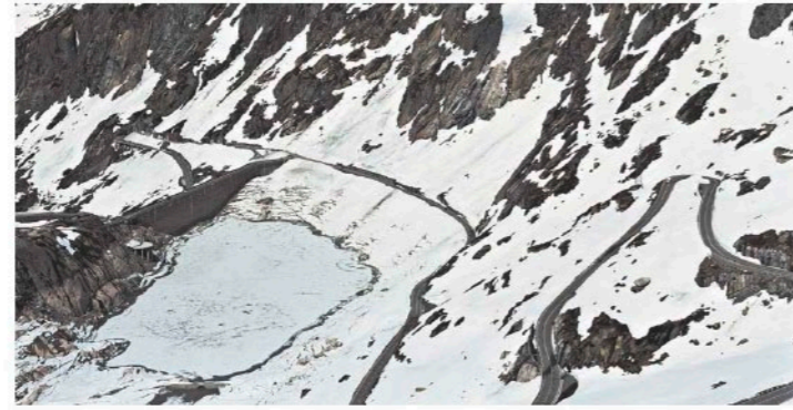
Grimsegg – Infrastrukturbauten Passstrasse & Staumauer, Fotografie Christian Helmle
