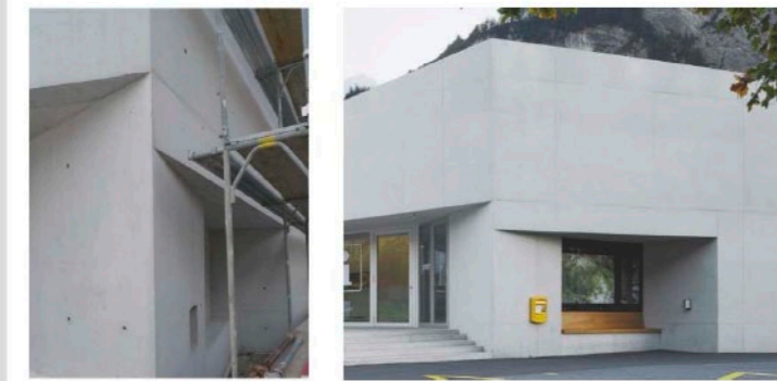
Baustellenprozess – Arbeitsfuge in Gehrung
