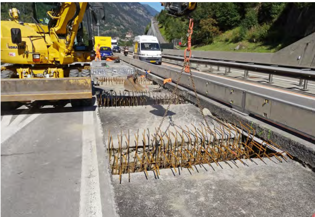
Bewehrung der Endverankerungen
