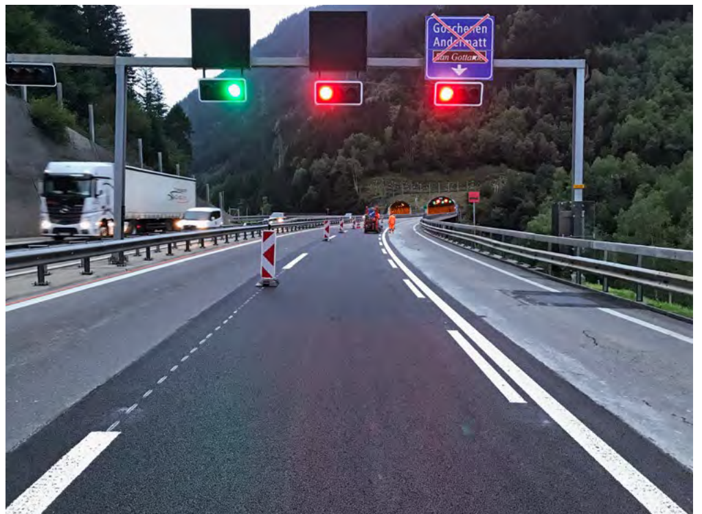
Bereit für die Verkehrsfreigabe (Blick Fahrtrichtung Süden)
