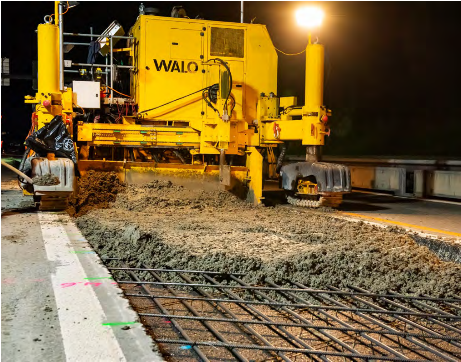
Maschinelles Einbau mit Gleitschalungsfertiger
