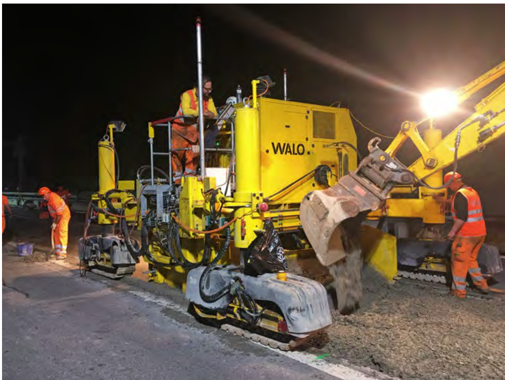
Maschinelles Einbau mit Gleitschalungsfertiger
