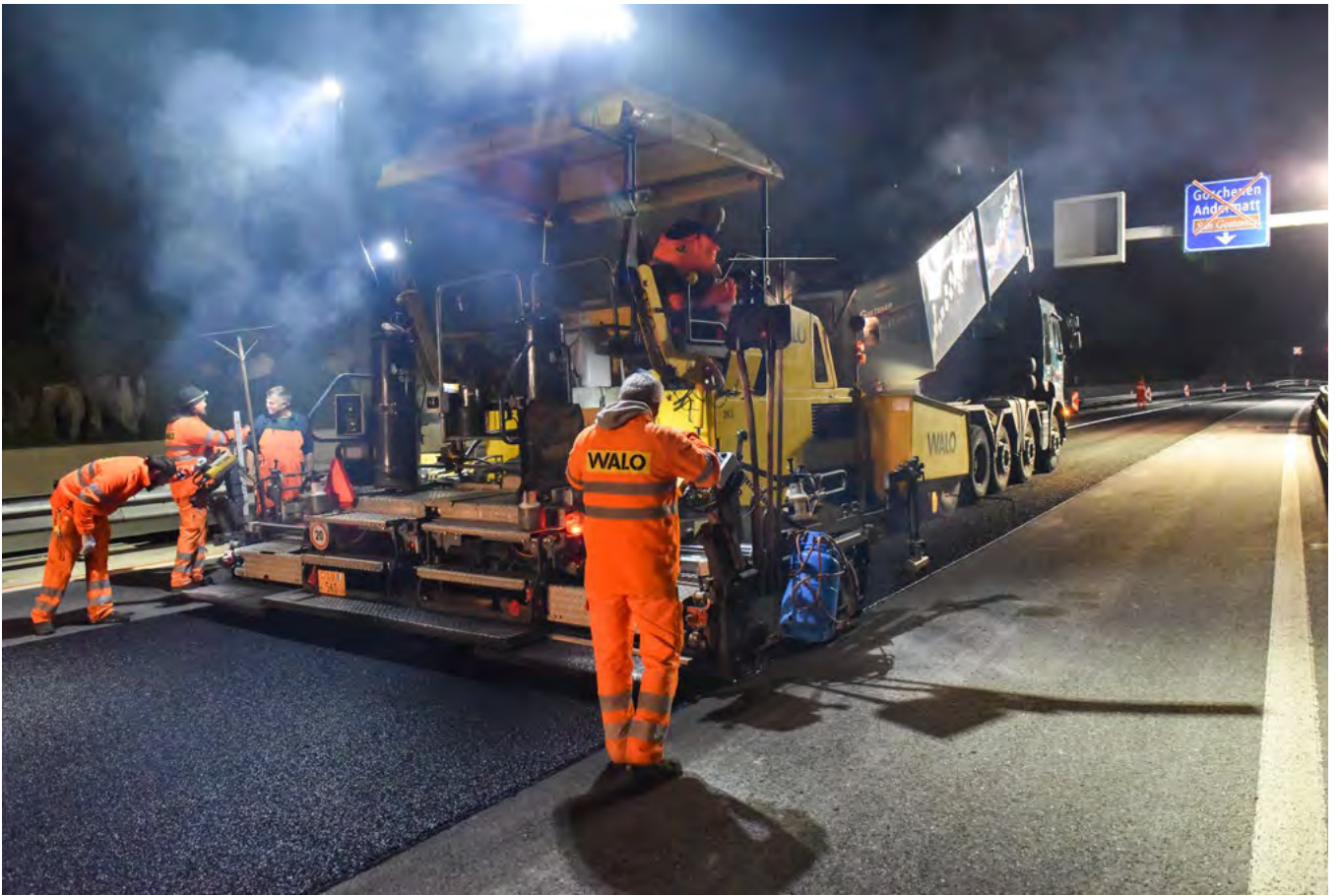
Deckbelagseinbau SDA 8-12
