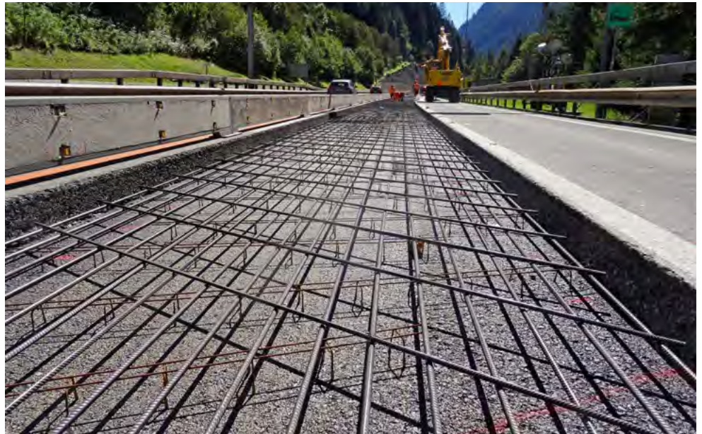
Verlegung der Längs- und Querbewehrung der Fahrbahn auf Asphalttragschicht AC F 22
