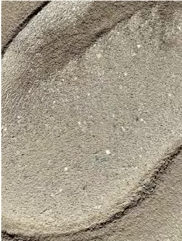
Betonoberfläche verzögert und Zementhaut entfernt (ausgebürstet)
