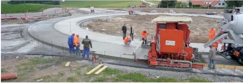
Bau eines Kreisverkehrs in Stapfenedt, Oberösterreich, mit Gleitschalungsfertiger Foto: Land Oberösterreich
