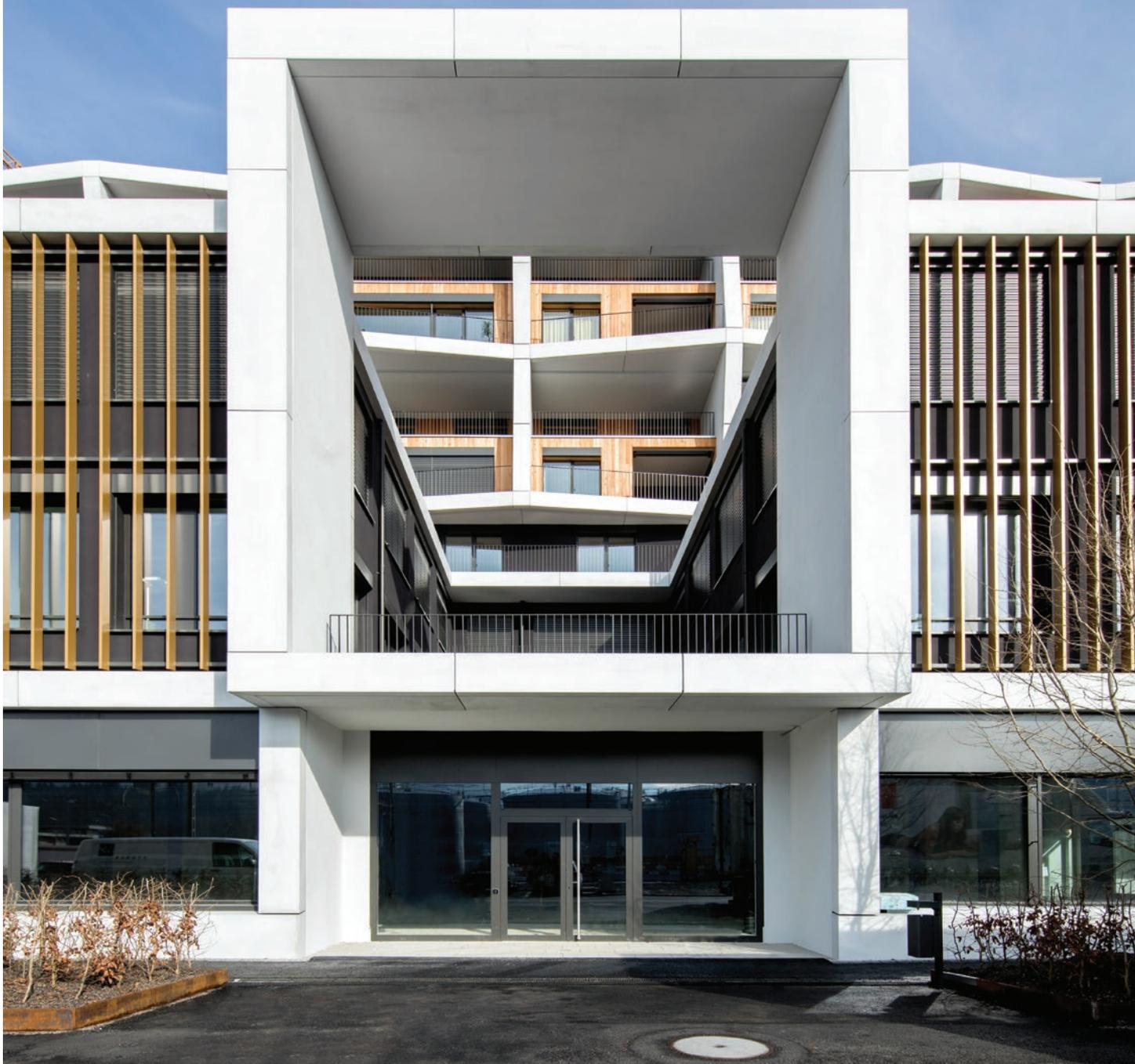
Fassadenelemente wurden aus Glasfaserbeton auf Basis von Weißzement hergestellt.
