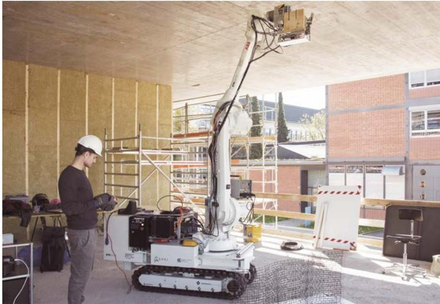
Links: Test des In situ Fabricator auf Empa NEST, Rechts: Robotisches Fügen von Holzplatten
