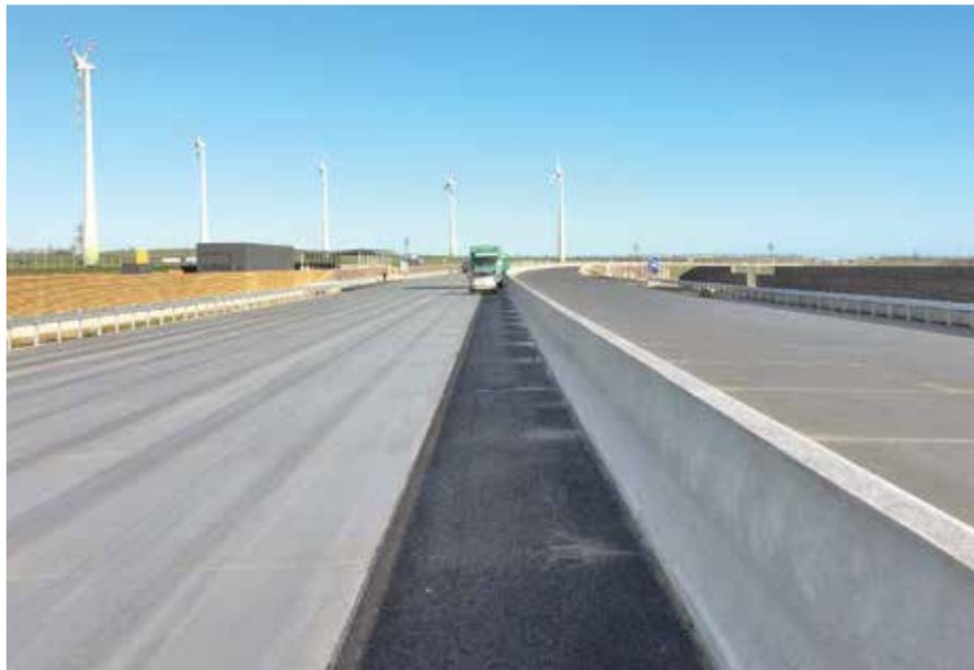
Exécution de la structure de grinding sur l'A5. En haut à gauche : arbre porteur avec meules diamantées
