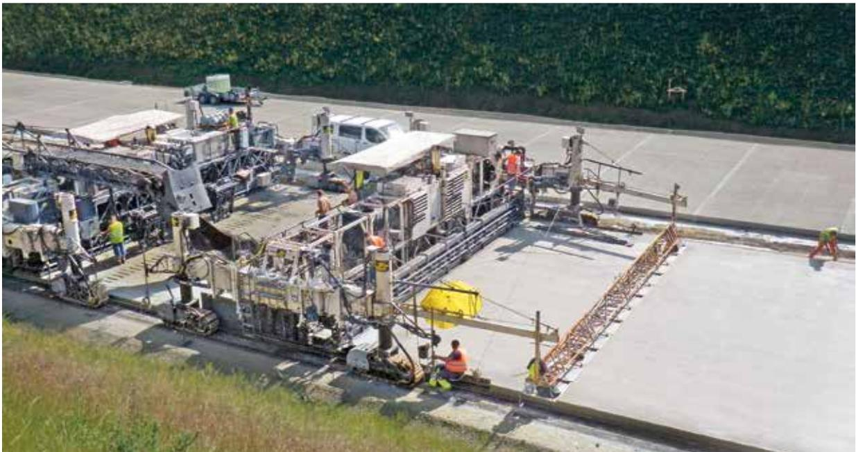
Mise en place de la dalle de béton.
