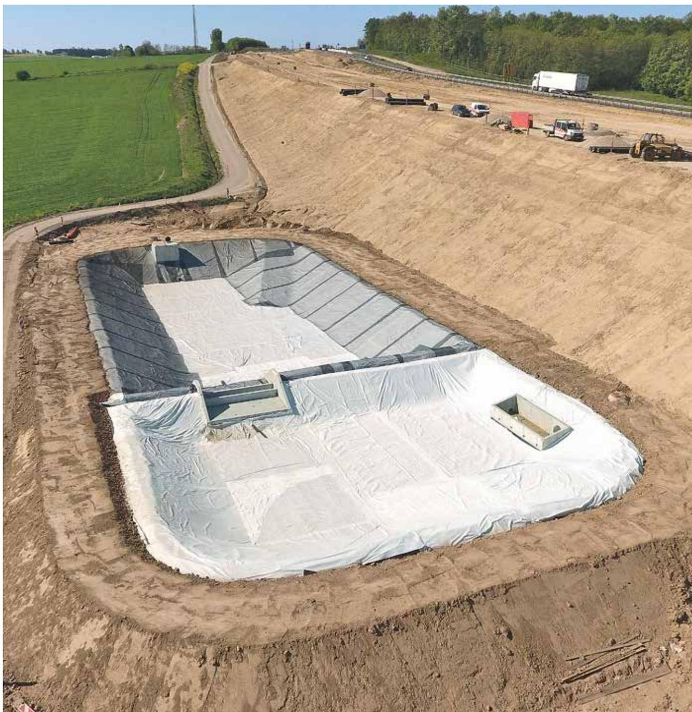
18 installations de protection des eaux sous surveillance ont été réalisées sur tout le tracé. Ici, une installation avec un bassin à deux niveaux.
