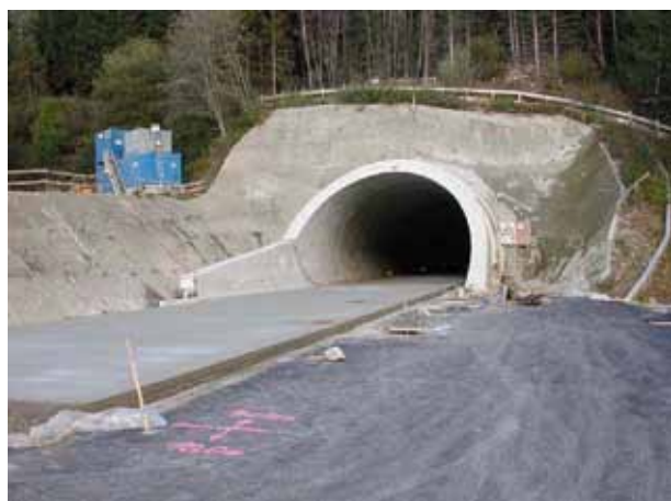
Fig. 4: Revêtement en béton dans le tunnel du Herzogberg, Südostbahn A2 Photo VÖZ
