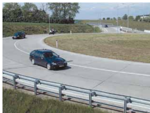
Fig. 5: Giratoire de Schwechat, Basse-Autriche Photo VÖZ
