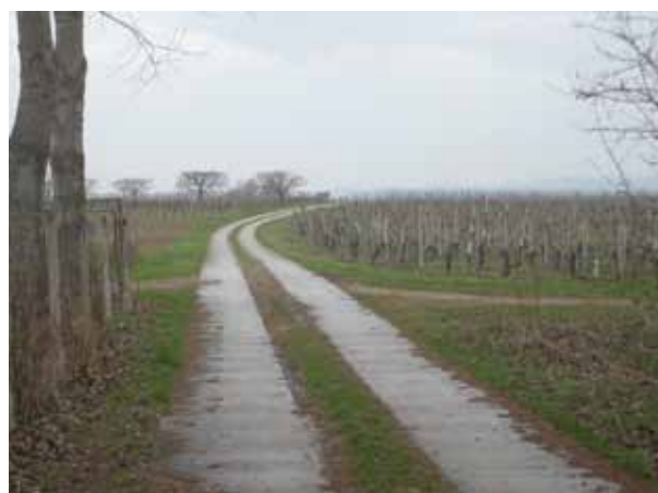
Fig. 8 : Bandes de roulement à Horitschon, Burgenland
