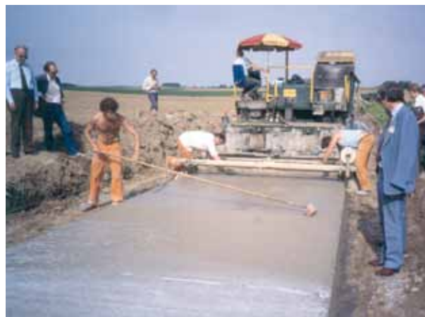
Fig. 7: Pose d'un revêtement au moyen d'une finisseuse
