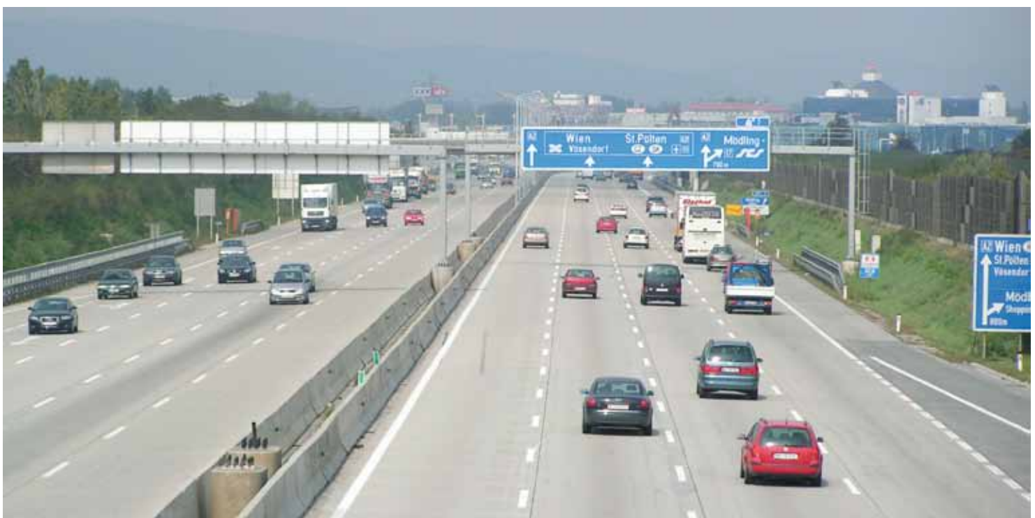
Fig. 1: Renouvellement général et élargissement de l'échangeur de Vösendorf (A) sur la «Südostbahn A 2», 2005 Photo VÖZ
