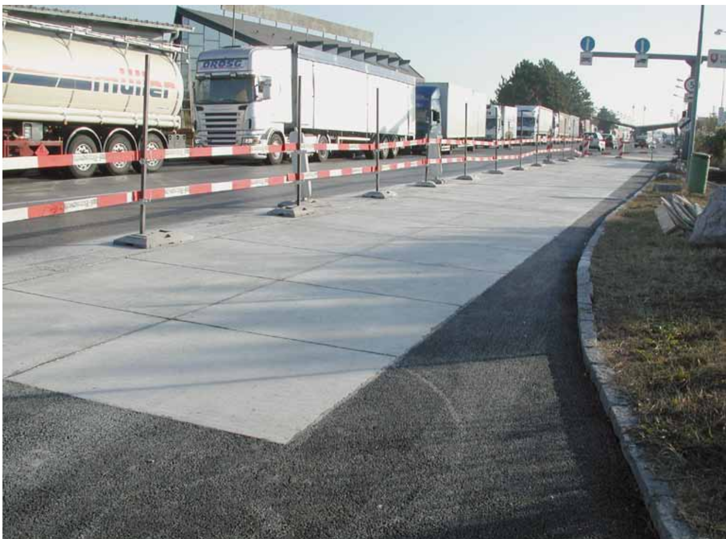
Fig. 6: White Topping à Berg (Basse-Autriche), piste pour poids lourds Photo VÖZ
