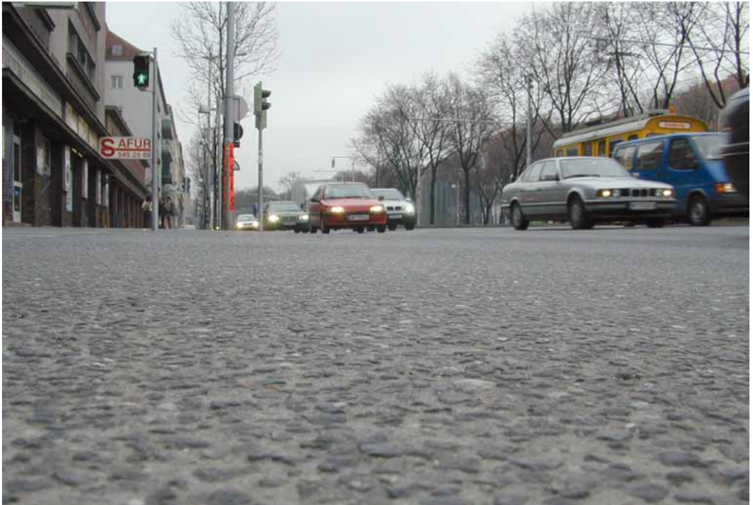
Fig. 3: Surfaces en béton lavé – Ceinture «Margareten Gürtel» à Vienne, 2007 Photo VÖZ
