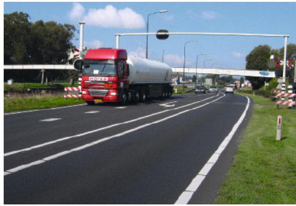
Figure 3: Couche d'asphalte mince sur dalle de béton aux Pays-Bas (Photo: Rolf Kampen)
