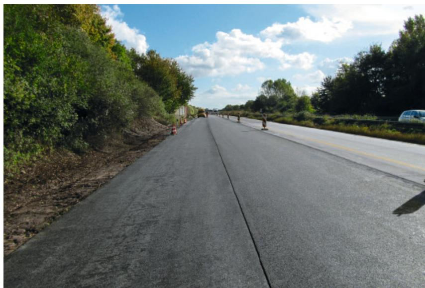
Figure 1 : Revêtement d'asphalte mince, phonique, sur béton / A61 (Photo: Rolf Kampen)
