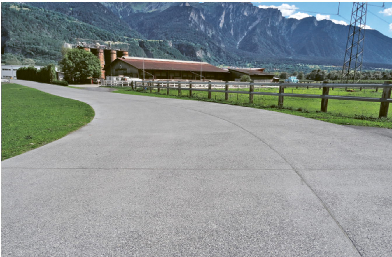
Vue sur la route de desserte à la fin des travaux avec fraisage et remplissage a posteriori des joints du revêtement
