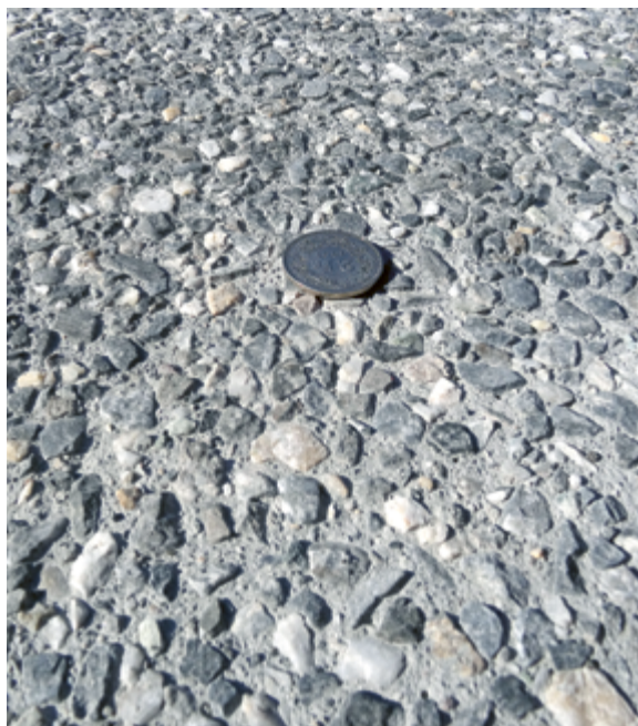
La surface en béton lavé assure une bonne adhérence et une forte réduction des émissions de bruit.
