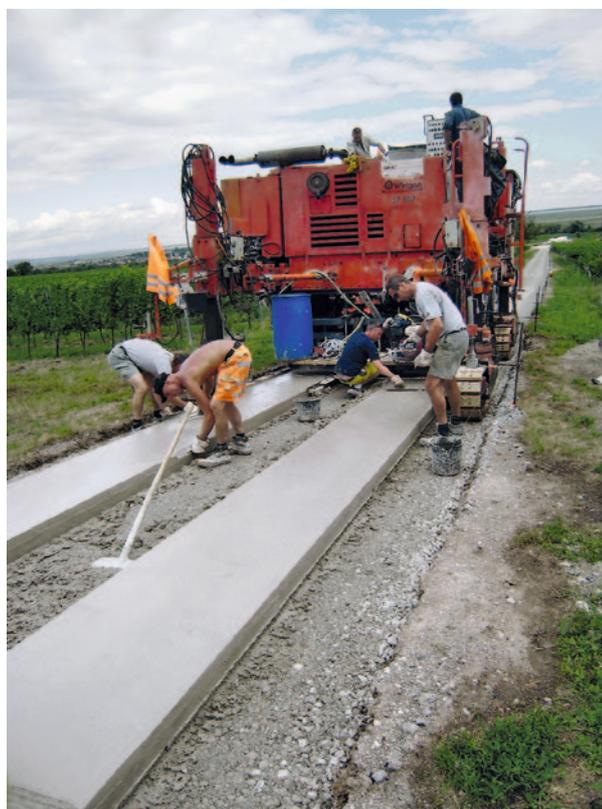
Fig. 1: Mise en place à la finisseuse: bandes de roulement à Rust/Oggau – Burgenland (A) 2011 (Photo VÖZ)
