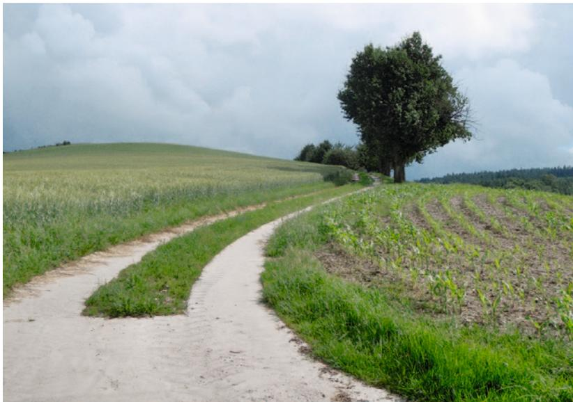
Fig. 5: Voie «Dallinger» terminée, formée de 2 bandes de béton, avec bande centrale et accotements végétalisés, Haute-Autriche (Photo VÖZ)
