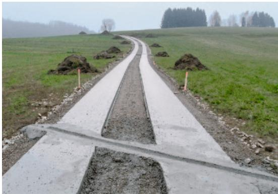
Fig. 4: Rigoles transversales pour l'évacuation de l'eau (photo Haslehner, Administration du Burgenland)
