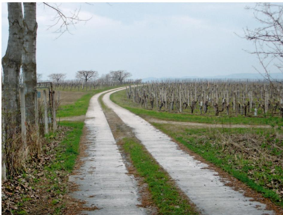
Fig. 2: Bandes de roulement en béton à Horitschon, Burgenland (Photo VÖZ)
